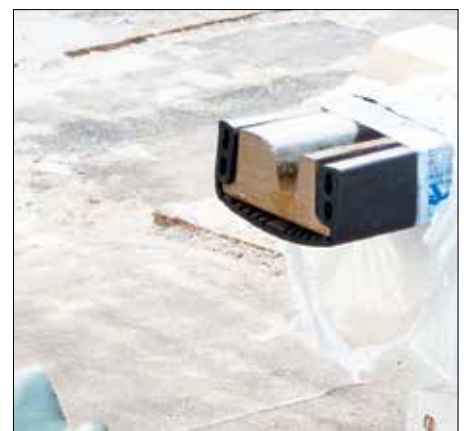
Rälens profil i kryssväxeln, här med gummiprofil.
