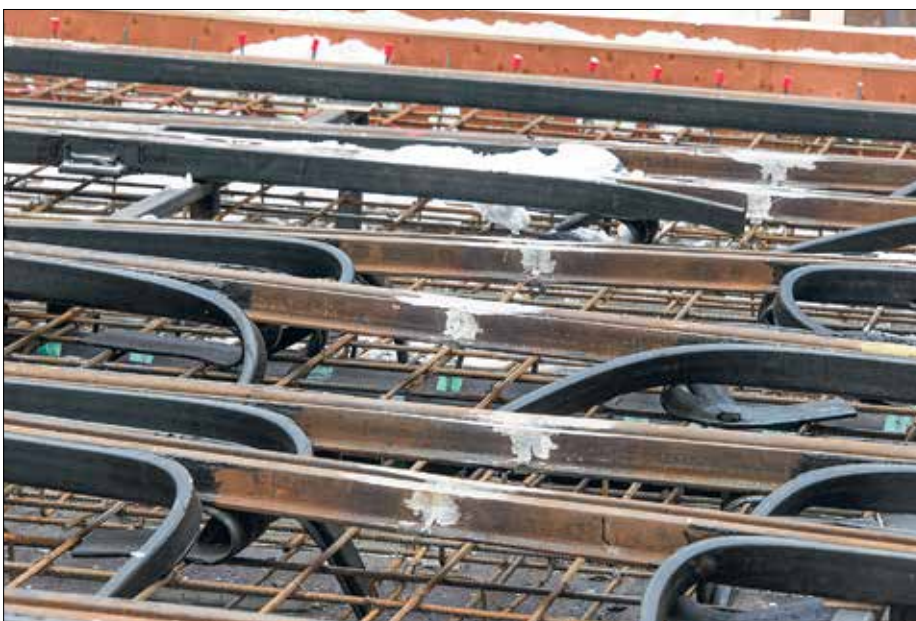
Kryssväxeln levererades i sektioner, med pålimmade gummiprofiler. Dessa fick vikas åt sidan i samband med svetsning när sektionerna sammanfogades. Efter svetsning limmas profilerna åter på plats.
