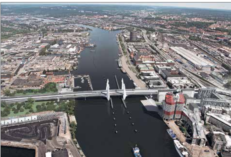
Den nya bron byggs med blygsam segelfri höjd, 12 meter, och utformas som en lyftbro. Det innebär att den rörliga brodelen lyfts i horisontellt läge. Fyra kraftiga pelare är tydliga kännemärken. Illustration: Dissing Weitling architecture
