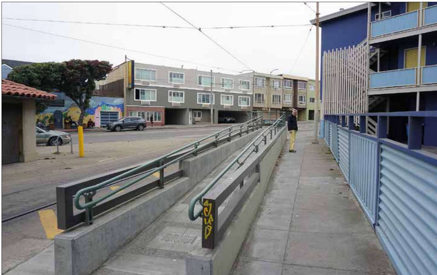
Ramp för rörelsehindrade vid påstigningshållplatsen vid Ocean Beach. För övriga trafikanter är hållplatsen bakom hushörnet, med påstigning från gatunivån.
