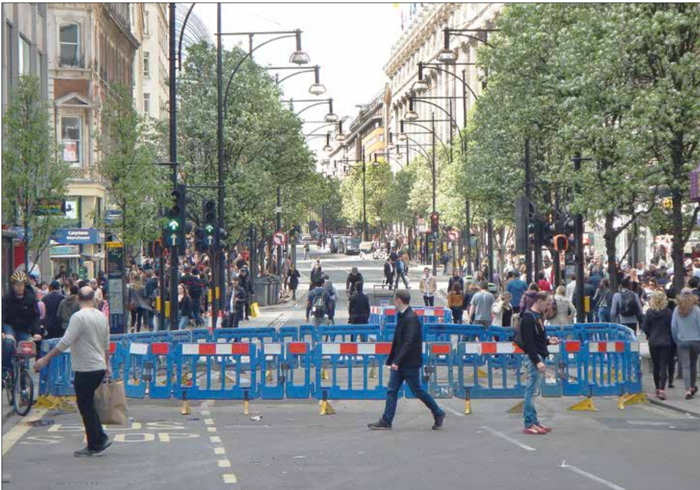
Gatuarbetet som gjorde att bussarna tvingades vända.
