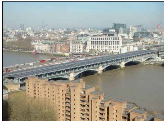
Plattformarna för de lokaltåg som utgår från Charing Cross ligger på en bro över Themsen. Bild tagen från utsiktståningen på konstmuseets Tate Moderns nybyggnad. Om man inte är konstintresserad bör man ändå gå hit för utsiktens skull (och det är ingen entréavgift!).
