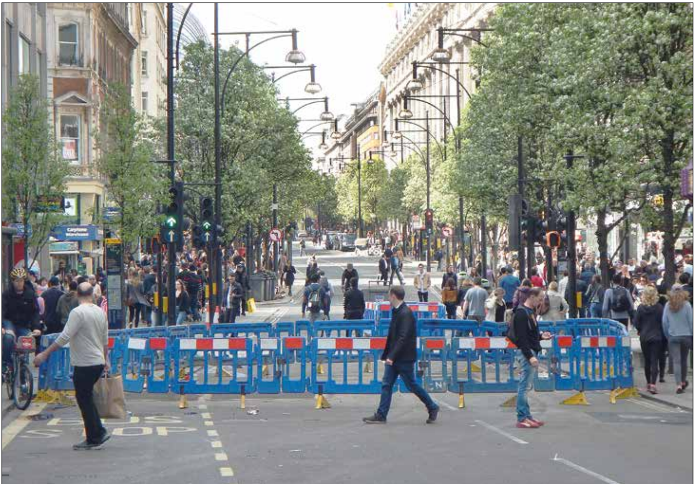
Gatuarbetet som gjorde att bussarna tvingades vända.
