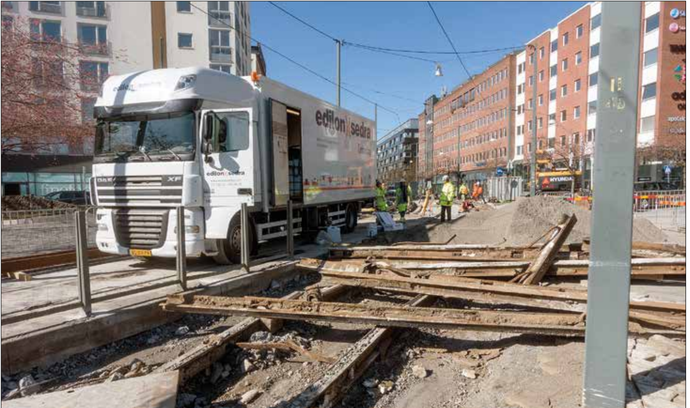
Vid hållplats Luma i Hammarby sjöstad har de ursprungliga spåren rivits upp och resterna syns i förgrunden. I bakgrunden kan anas att arbete med nya spår pågår. Edilon Sedra är på plats med arbetsfordon för inledande arbeten.
