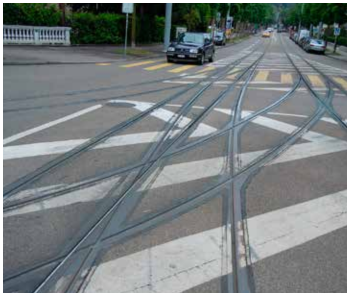
Det krävs ett visst hantverk för att knäpa ihop ett snyggt växelkomplex. Detta hittar man på Münchensteinerstrasse i schweiziska Basel.
