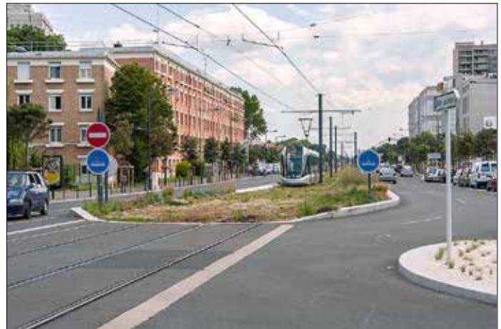
Nya spårvägslinje T7 i södra Paris, nära ändhållplatsen i Villejuif. Notera grässpår (sedum, tåligt mot torka) och gracil kontaktledning.
