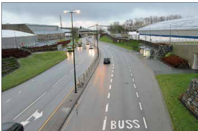
Västerut mot Tananger finns de först byggda busskörfälten som idag är sidoförlagda vilket ger sämre framkomlighet i cirkulationsplatser.
