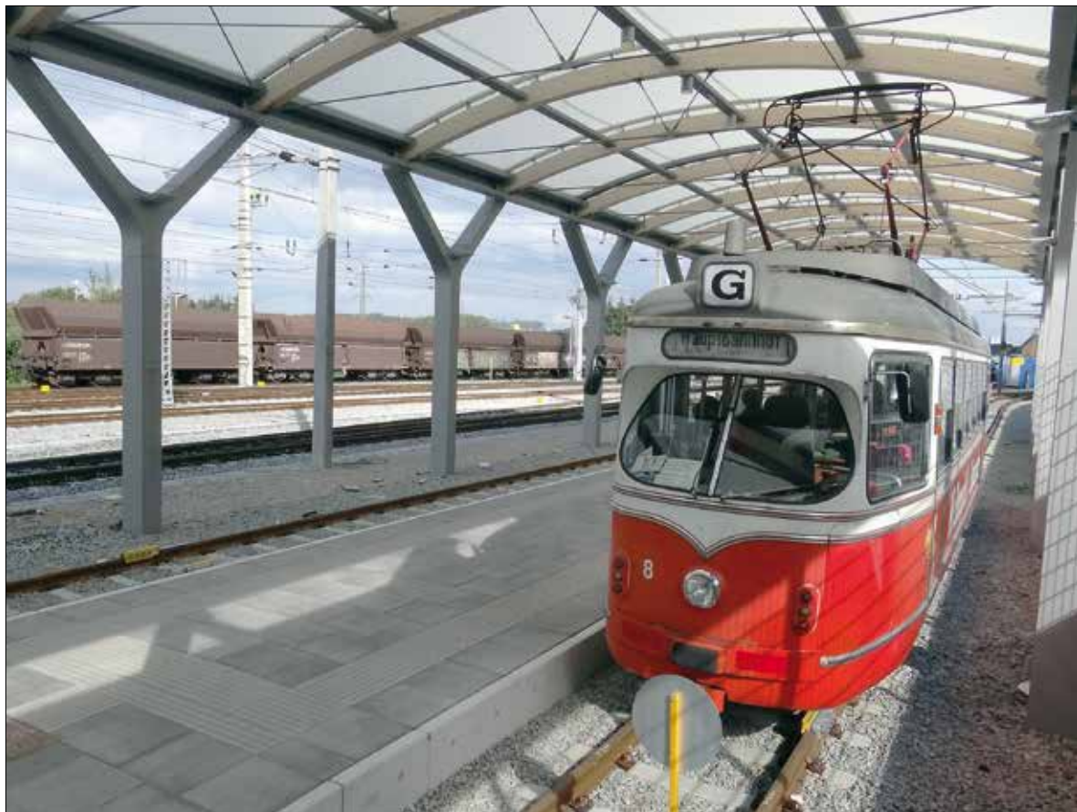
Den direkta kontakten för Gmundens spårväg till Gmundens ÖBB-station är sedan maj 2015 utförd som en dubbelspårig ändhållplats med mittplattform. Foto: Otfried Knoll
