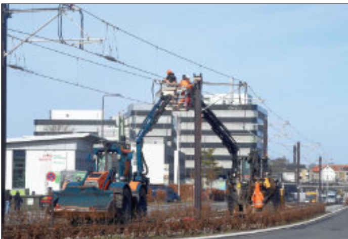
Spårgående gummihjulsfordon har det varit gott om vid bygget av Letbanen. Här utförs sista-minuten-arbeten med kontaktledningen mellan Gladsaxe och Buddinge station (i fonden) innan första spårvagnen kan passera på eftermiddagen den 17 mars.
