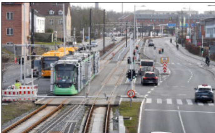
Spårgående gummihjulsfordon har det varit gott om vid bygget av Letbanen. Här utförs sista-minuten-arbeten med kontaktledningen mellan Gladsaxe och Buddinge station (i fonden) innan första spårvagnen kan passera på eftermiddagen den 17 mars.
