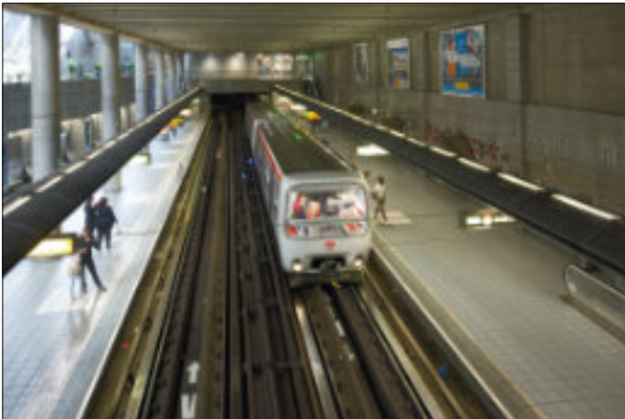
Inte någon bana på viadukter, men väl en automatunnelbana med passagerarplatser längst fram: tunnelbanelinje D i Lyon vid ändhållplatsen Gare de Vaise. Foto: Thomas Johansson
