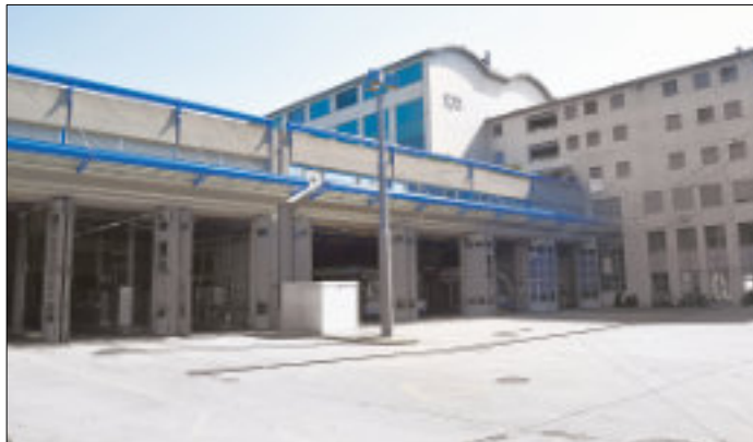
Trådbussdepån sommaren 2025. Kontaktledningsanläggningen är väsentligt förenklad, jämfört med bilden till vänster.
