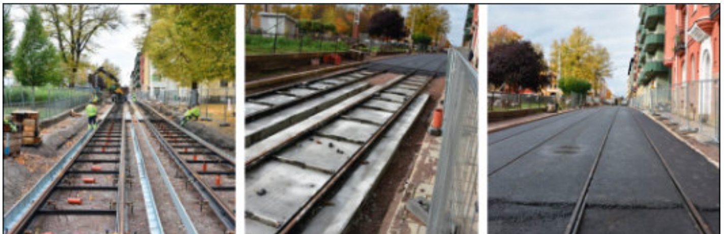
Rälsjustering i höjd och sidled
