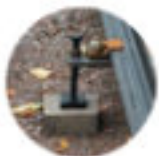
Rälsjustering i höjd och sidled
