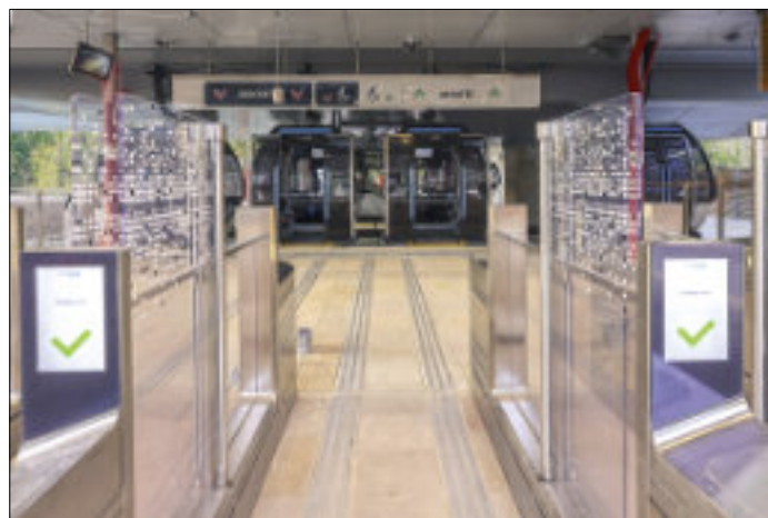
Entré till linbanan med automatspärarr. Förbindelsen är helt integrerad med övrig kollektivtrafik.
