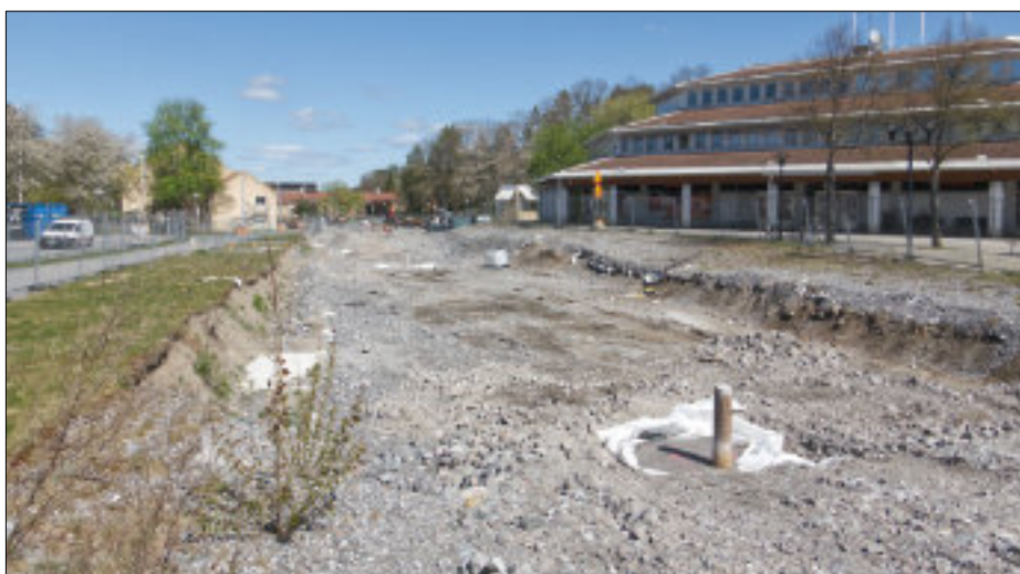
Tvärbanan ska passera tätt intill centrumbyggnaden i Rissne som syns till höger. På bilden från maj 2024 framgår att arbeten med nya fundament för kontaktledningsstolparna har inletts. De stora betongfundamenten av järnvägsmodell som ursprungligen hade utplacerats togs åter bort när det hade beslutats att banan ska byggas med ballastfritt spår.
