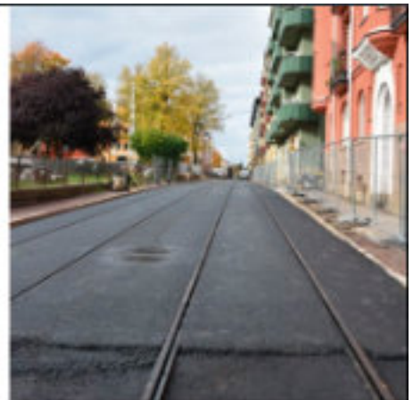
Isolering av avvattningssläder och spårhållare
