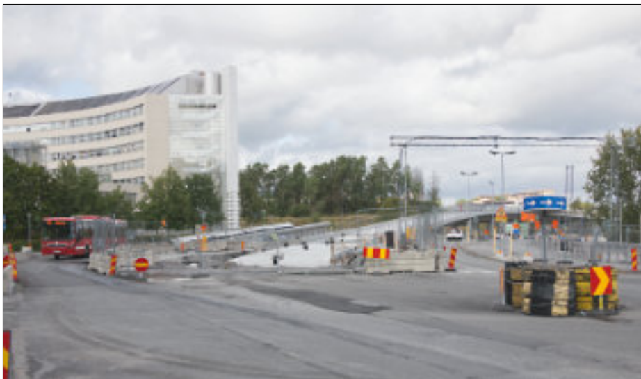
Kistagrenens bro över Enköpingsvägen är 365 meter lång och klar sedan länge. Bron får den brantaste lutningen i hela tvärbanenätet med 6 procent.
