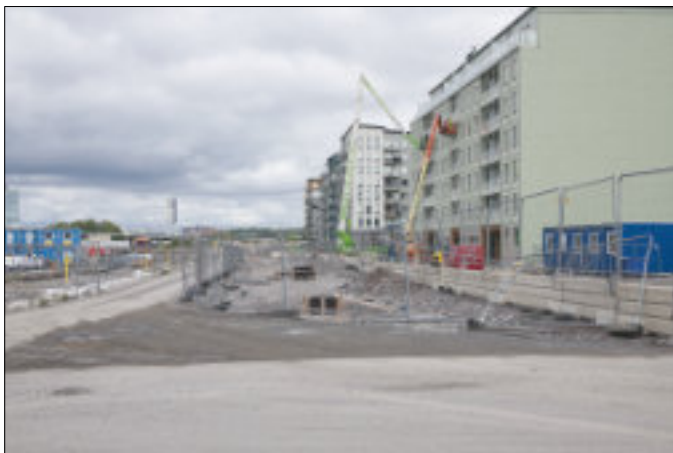
I Ursvik är Tvärbanans blivande sträckning och blivande (tillfälliga?) ändhållplats noggrant inhägnad. Därtill är hela området inhägnat eftersom stora arbeten pågår med nya bostadshus.
