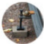
Rälsjustering i höjd och sidled
