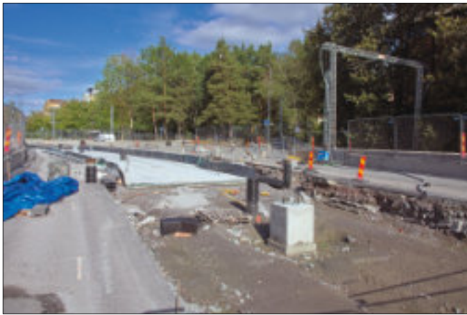
I Kavallerivägen pågick arbeten med betongunderlag och stolpfundament i princip fram till byggstoppet för ett år sedan.
