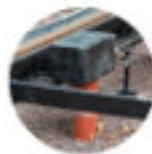
Isolering av avvattningssläder och spårhållare
