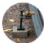
Rälsjustering i höjd och sidled
