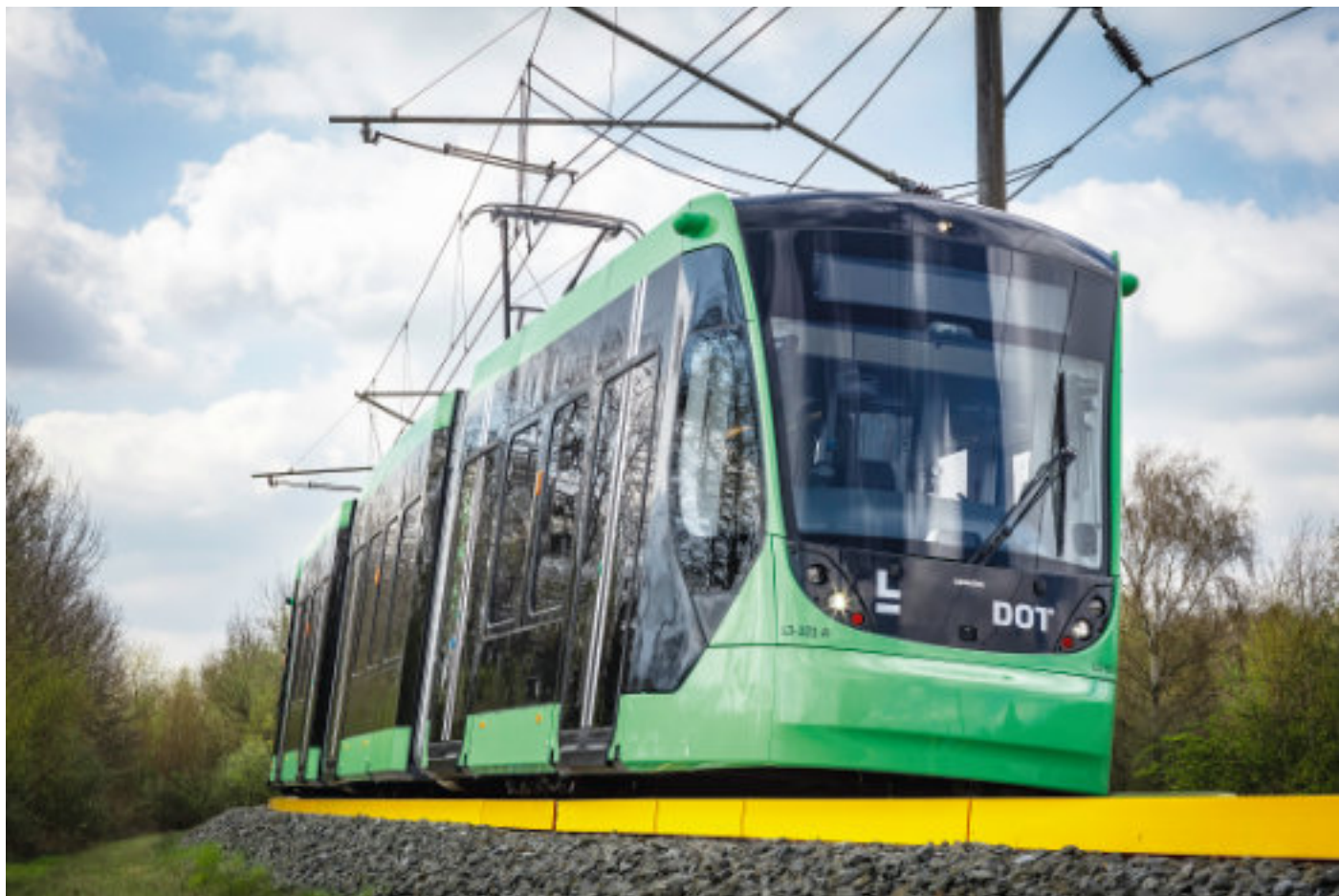
Den 21 februari 2025 spänns kontaktleddningen för första gången på spårvägen mellan Glostrup och Ishøj. Nu finns elkraft på hela sträckan mellan Ishøj och Rødovre Nord som invigs i höst. Foto: Hovedstadens Letbane
