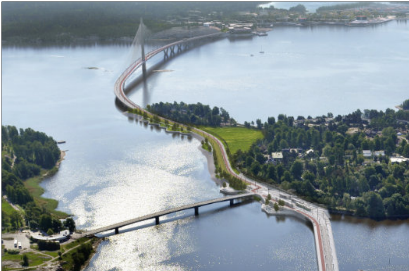
Linjen över Kronbroarna omfattar den längsta bron i Finland, 1 200 meter lång, som endast ska användas för spårväg, fotgängare, cykeltrafik och räddningstjänst. Andra broar byggs också för att ansluta bebyggelsen. Foto: Kaupunkiliikenne Oy, WSP Finland, Knight Architects
