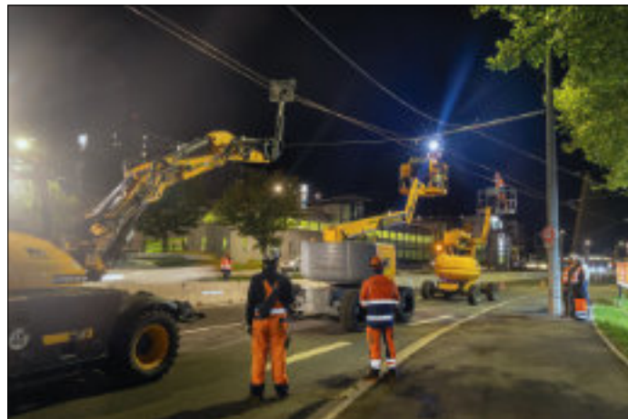
Montering av kontaktledning för nya trådbusslinjen i Nancy den 12 september 2024. Foto: Khaled Frikha, Grand Nancy
