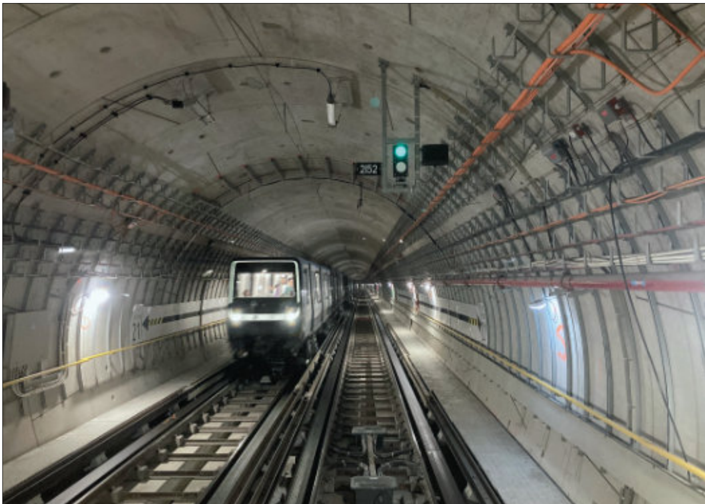
På invigningsdagen den 24 juni 2024 ankommer ett av de första tunnelbanetågen till nya stationen Aéroport d'Orly. Notera spårkonstruktion för gummihjulståg. Foto: Patrick Laval
