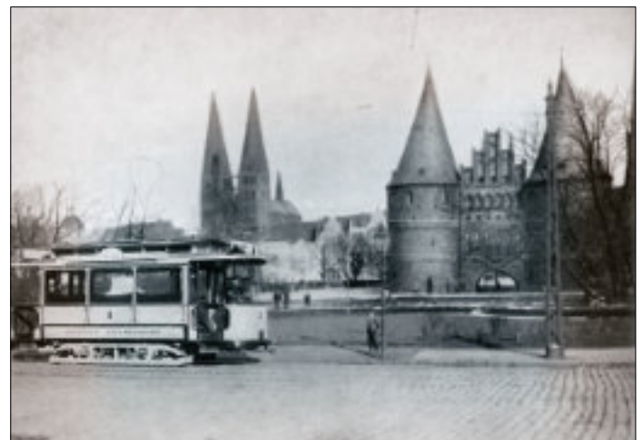
Spårvagn vid Holstentor 1908. Vagnen var tillverkad av Falkenried 1905, med elektrisk utrustning från Siemens. Foto: Stadswerke Lübeck
