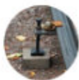
Rälsjustering i höjd och sidled
