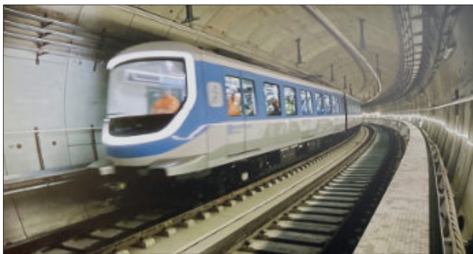
De inbjudna gästerna vid presentationen av det första Grand Paris Express-tåget kunde 2023 färdas några hundra meter ombord, på förbindelsen som leder till CEM i Champigny-sur-Marne. Notera kontaktledningen i form av en skena i tunneltaket.
