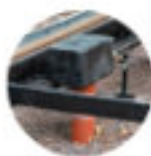
Isolering av avvattningsslådor och spårhållare
