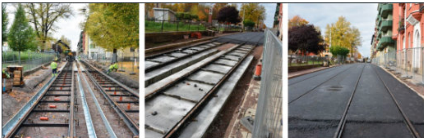
Rälsjustering i höjd och sidled
