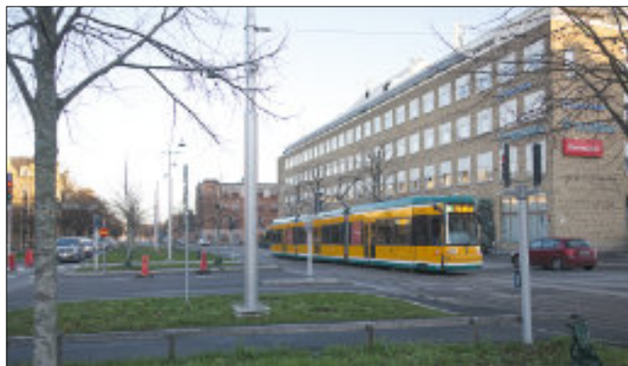
Östra promenaden i Norrköping är helt omdanad. De gamla alléträden har ersatts med nya, alltjämt på tillväxt. Nya kontaktledningsstolpar glänser i morgonljuset.
