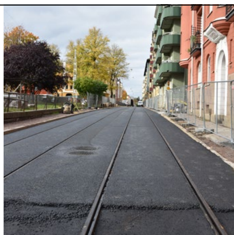
Isolering av avvattningsslådor och spårhållare
