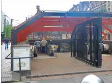
Nedgång till tunnelbanestationen St Enoch som ligger nära centralstationen i Glasgow.
