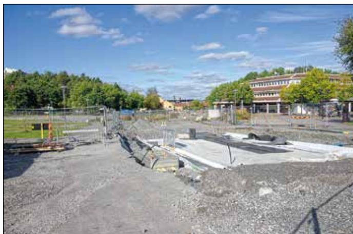
Bild från hösten 2024 visar spårvägens sträckning genom Rissne centrum med nedgång till tunnelbanan till höger utanför bilden. Mitt i bild, till vänster om centrumhuset, anläggs spårväghållplatsen.
