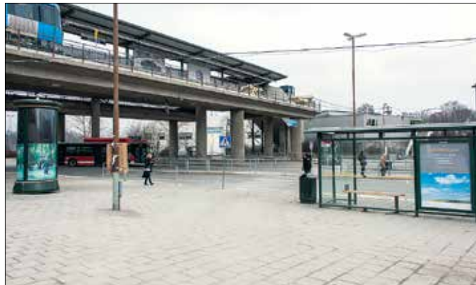
I Ropsten ska Spårväg city och Lidingöbanan kopplas samman, exakt hur är inte klart. I bakgrunden till höger syns Lidingöbanans provisoriska ändhållplats från 1967; tunnelbanan planerades då fortsätta på bro till Lidingö.
