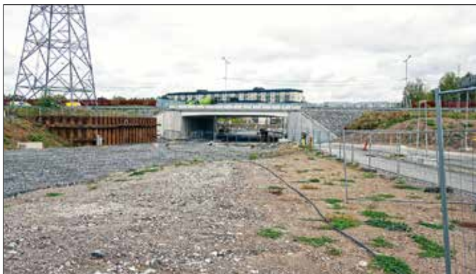
Sedan en tid är den nya viadukten för E4:an nära Helenelunds pendeltågsstation färdig. Här ska Kistagrenen i framtiden passera.
