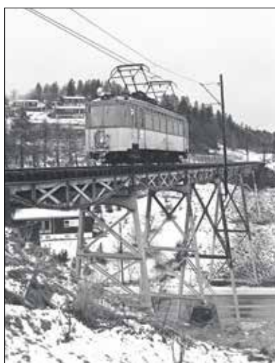
Hoemsbron på Gråkallbanen i Trondheim 1980. Bron är 90 meter lång och byggdes ursprungligen runt 1918 som järnvägsbro över älven Funna i Meråker. Den byttes ut 1923 när axellasterna höjdes på Meråkersbanen och kom då till användning på Gråkallbanen från trafikstarten 1924.
