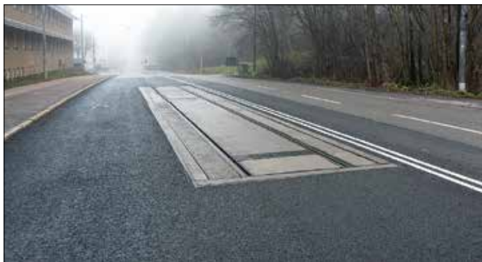
Ännu hösten 2014 levde utbyggnadsplanerna till Ropsten ett aktivt liv, med installation av tre provkroppar med spårvägsspår av olika konstruktion i Lindarängsvägen.
