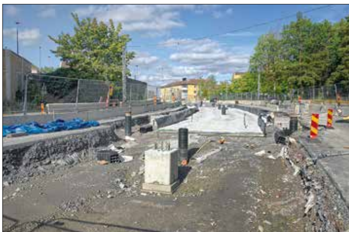
Kavallerivägen mellan Solvallabron och Rissne centrum hösten 2024. Gjutna betongplatta och nya platsgjutna fundament för kontaktledningsstolpar antyder att här kan det så småningom bli en spårväg.
