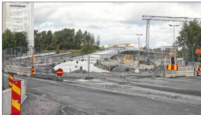
Bron över Enköpingsvägen är klar, men spår och andra installationer för spårvägen återstår.
