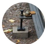
Rälsjustering i höjd och sidled
