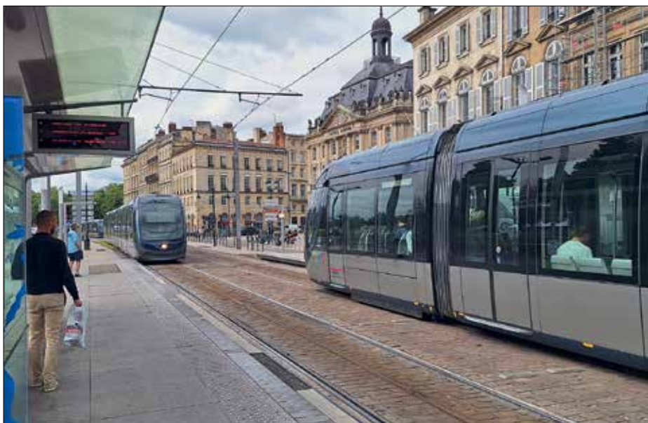
Vid denna hållplats byter spårvagnarna elkraftstillförsel från kontaktledning till strömskena, och vice versa. Eftersom spårvagnarnas släpskor har slitytor av gjutjärn noteras viss rostfärgning av markområdet närmast strömskenan.
