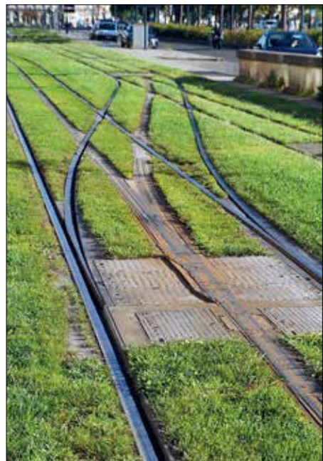
Spårteknik i den högre skolan: Övergångsväxel i Bordeaux med strömtillförsel via tredje skena, system APS.
