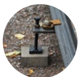
Rälsjustering i höjd och sidled
