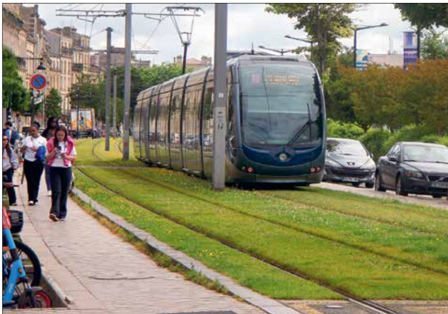
Spårvägen i Bordeaux är separerad från övrig trafik och inslaget av grässpår är stort, också i de centrala delarna. Som vanligt i Frankrike noteras en öppen spåranläggning, utan staket och andra barriärer.
