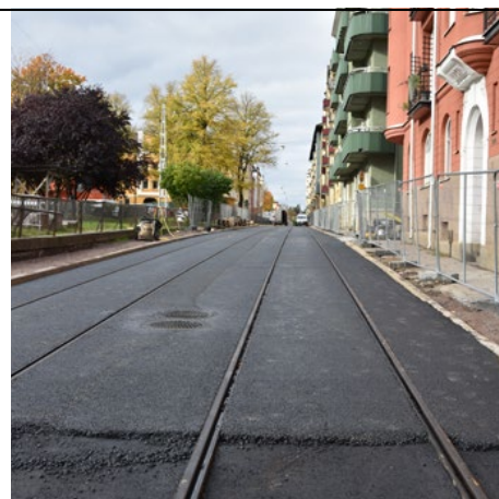
Isolering av avvattningsslådor och spårhållare
