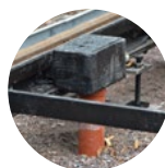
Isolering av avvattningsslådor och spårhållare
