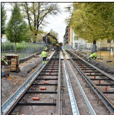
Rälsjustering i höjd och sidled
