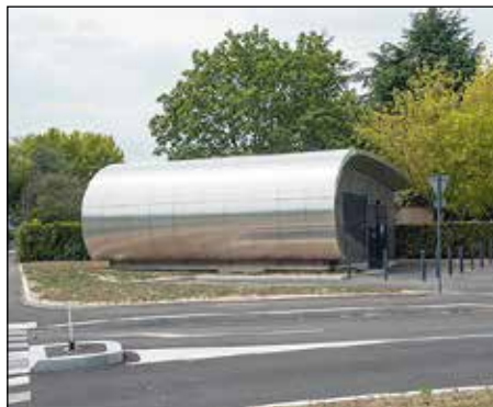
Hus för likriktaranläggning vid spårvägen i Angers i Frankrike, möjligen formgiven enligt mottot: "Det man inte kan dölja får man framhäva".
