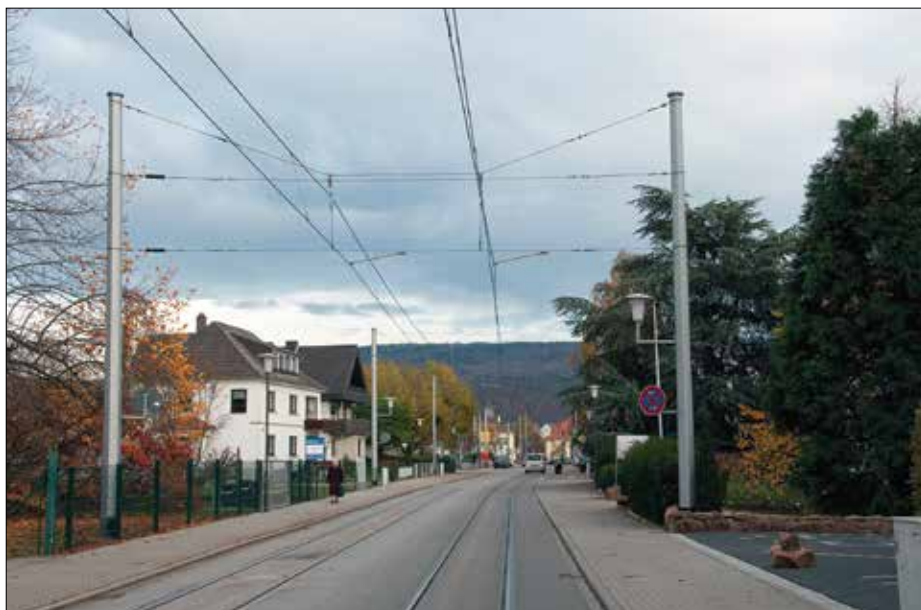
Modifierad kontaktledningsteknik från järnvägen, körtråd med ovanliggande bärlina och däremellan på regelbundna avstånd vertikala bärtrådar. Tillsatsrör håller körtråden i korrekt position i sidled. Bild från gatuspårvägssträcka i Kirchheim utanför Heidelberg.
