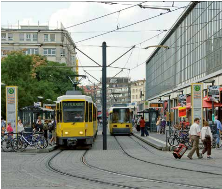
I Tyskland vanlig kontaktledningskonstruktion vid spårvägar. Järnvägsnärlig prägel, används även i tät stadsmiljö, som här nära Alexanderplatz i Berlin.
