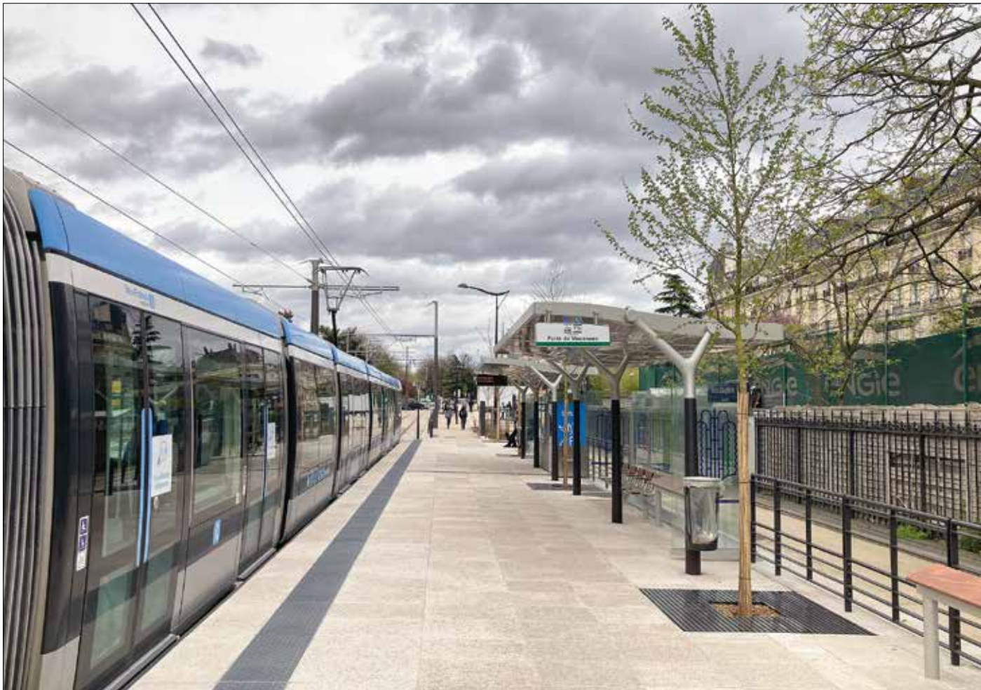
Vid ändhållplatsen Porte Dauphine noteras att taket på väntkurerna följer formspråket vid tidigare hållplatser på T3-linjerna, enligt mottot "kurva och motkurva". Detta gäller även belysningsstolpen i bakgrunden. Däremot märkligt nog inte kontaktledningens stolpe med utliggare. Bakom fotografen finns kryssväxel med uppställningsspår.
