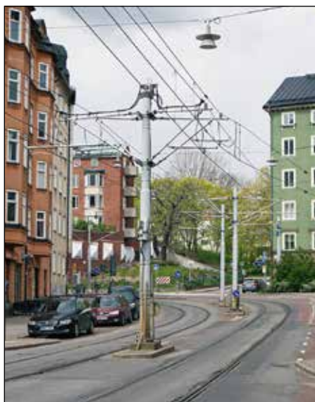
Inte det snyggaste vi har sett: kontaktledningsanläggning för Tvärbanan i Gröndal i Stockholm i järnvägmässigt utförande, med mittstolpar i körbanan, här dessutom mekaniskt sektionsbyte vilket på ett par hundra meter ger åtta parallella trådar. Diverse kabelförbindelser och utanför bilden vikter för uppspänningen hängande utanpå stolpe.
