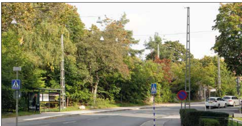
Stolpar som är kvar från trådbusstiden vid Sköntorpsplan i Stockholm. Stolparna lutar nu två à tre grader utåt (bort från gatan). Vid den tidigare belastningen från trådsystemet (1954–1965) stod de i det närmaste lodrätt, eller med ytterst svag lutning utåt.
