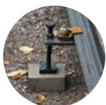
Rälsjustering i höjd och sidled
