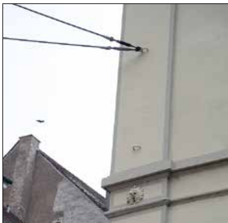
Underst klassisk väggröset, däröver ett icke använt modernt väggefäste och överst ett som är i bruk.
