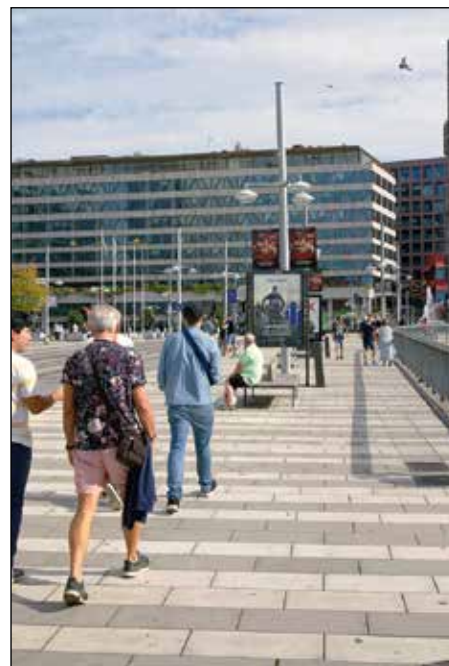
Av belastningen lätt böjd stolpe vid Sergels torg i Stockholm. Stolparna monterades i det närmaste lodrätt. Viss lutning bort från gatan bör eftersträvas vid stolpmontering.
