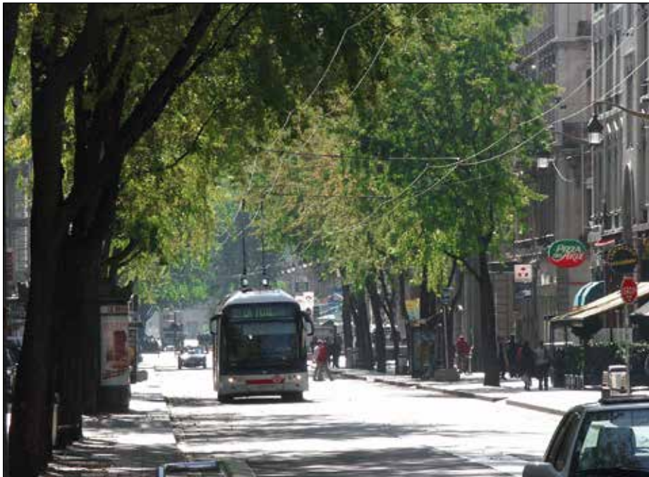
Ett tilltalande sätt att dölja en kontaktledningsanläggning är att utnyttja alléträ. På denna bild från en allégata i Lyon avslöjar endast reflexerna under körträderna anläggningens existens.
