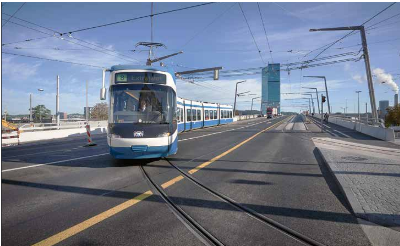
På denna bild framgår den spektakulära spårförläggningen på Hardbrücke, där spårvagnarna signalreglerat korsar biltrafikens körfält. Bussar och spårvagnar delar sidoförlagda kollektivtrafikfält, medan biltrafiken använder de båda fälten i mitten. Breda gång- och cykelbanor finns på båda sidor. Foto:VBZ
