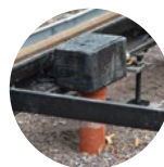
Isolering av avvattningslådor och spårhållare
