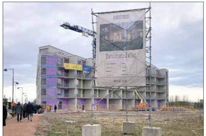
Stadsdelen Brunnhög växer upp runt spårvägen. Byggarbeten pågår vid Brunnhögstorget, Sveriges högst belägna spårvagnshållplats, 87 meter över havet.
