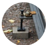
Rälsjustering i höjd och sidled
