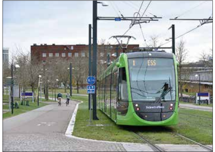
Spårvägen i Lund går till största delen på grässpår, anläggningen är öppen, utan staket eller andra barriärer. På bilden syns tydligt den så kallade vita linjen som avgränsar mot övrig trafik. Utmed så gott som hela sträckningen löper parallellt en gång- och cykelbana.
