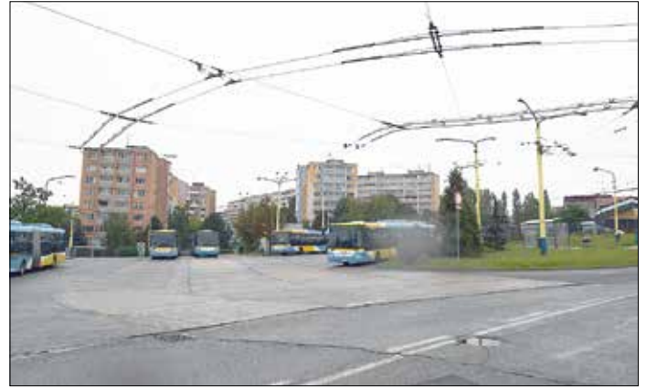
Vid ändhållplatsen Lingov i Kosice finns stora bostadskvarter vilket tyder på högt passagerarunderlag. Härifrån gick trådbusslinjerna 71 och 72. Kontaktledningsnätet är fortfarande intakt.
