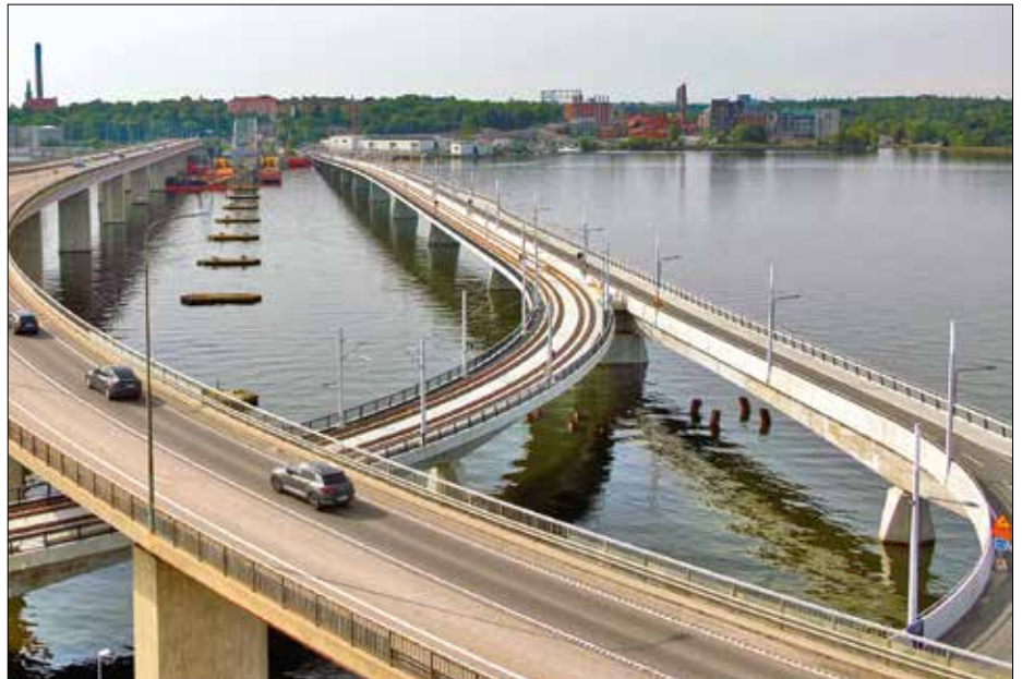
Lilla Lidingöbron står klar sedan länge, den gamla bron är riven, så när som på pelarfundamenten. Spårvägstrafiken över bron är ännu i början av mars 2024 inte invigd. Vid pressläggningen antyds att den skulle kunna vara igång från den 28 maj.
