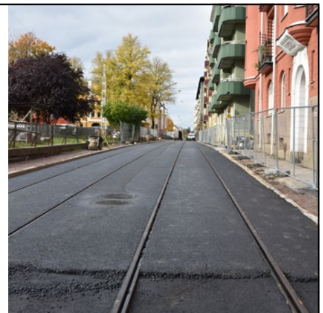
Isolering av avvattningslådor och spårhållare
