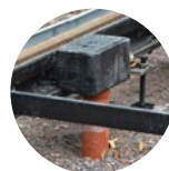
Isolering av avvattningsslådor och spårhållare
