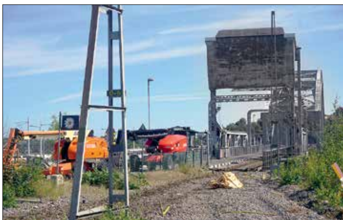
Spåranslutningen till gamla Lidingöbron vid Ropsten är riven.
