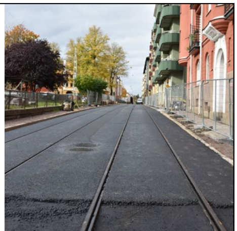
Isolering av avvattningsslådor och spårhållare
