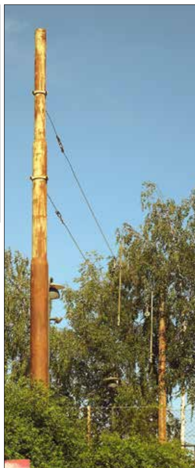
Rörstolpar vid terminalen i Ropsten. De härstammar från 1967 när anläggningen byggdes. Har de målats sedan dess?
