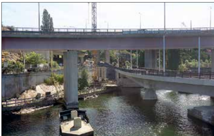
Anslutningsarbeten för Lidingöbanan pågår vid Torsvik.
