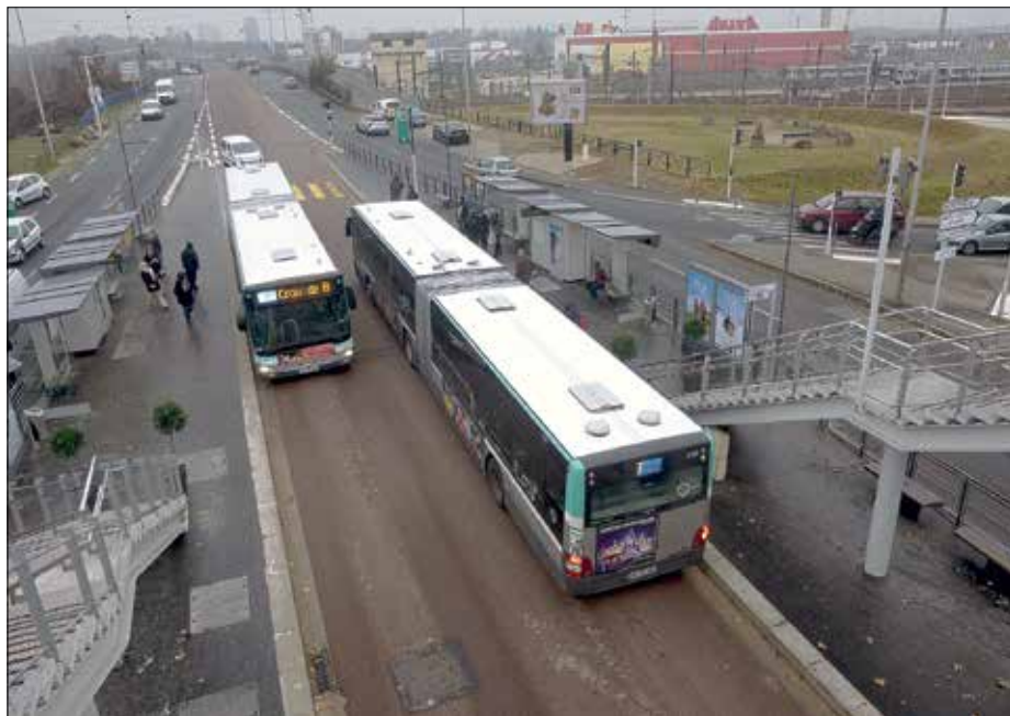
Bussbanan Trans Val-de-Marne, TVM, öppnades 1993, förlängdes 2007 till nuvarande utförande och är omkring 20 kilometer lång. Den framgår till stor del i mitten av hårt trafikerade vägar, ofta med många köfält. Barriäreffekten är på vissa passager mycket stor. TVM var ingen förebild för departementet Hauts-de-Seine.
