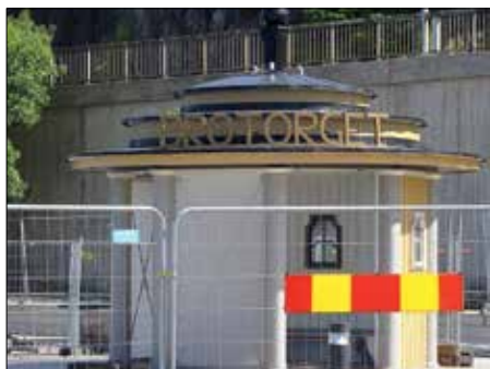
Vindarnas tempel kallas den lilla byggnad som stod på gamla Lidingöbronns norra landfäste, i gränspunkten mellan de norra och södra banorna. Den har renoverats och flyttats till norra landfästet för Lilla Lidingöbron.
