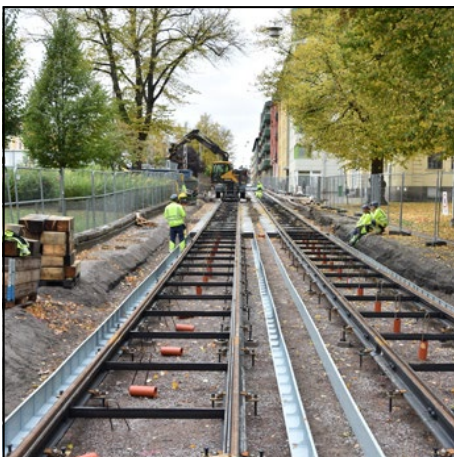
Rälsjustering i höjd och sidled
