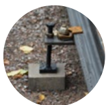
Rälsjustering i höjd och sidled
