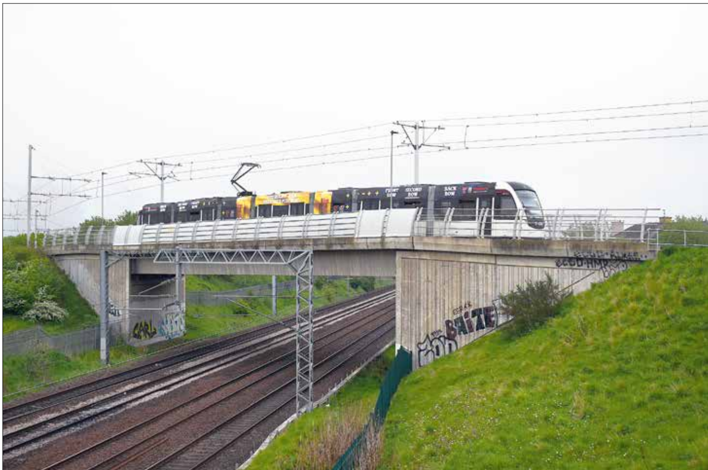
Gemensam gång-, cykel- och spårvägsbro mellan Balgreen och Saughton, vilken gör att spårvägslinjen kan föras till andra sidan av järnvägslinjen mot Glasgow och skotska höglandet. Foto: Geoffroy Brocart
