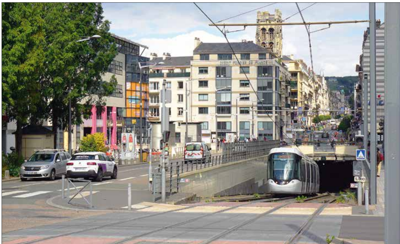
Centrum i Rouen passeras i tunnel, med fyra hållplatser. Här lämnar en av de 27 nya spårvagnarna av typ Alstom Citadis 402 tunneln för att omedelbart köra ut på bron över Seine. Vagntypen är nästan 44 meter lång och 2,40 meter bred. Serien ersatte 2012–13 den ursprungliga vagnparken TFS 2 från 1994, 28 stycken. Dessa såldes därefter till staden Gaziantep i Turkiet.
