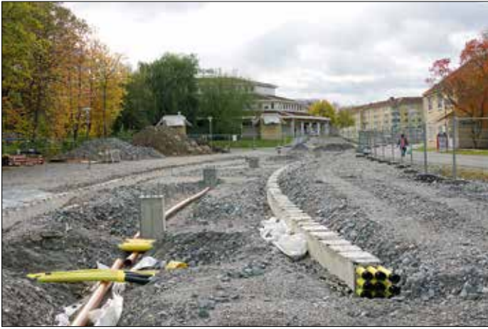
Stolpfundament och kabelkanaler har utplacerats, här mellan Rissne centrum och Artillerivägen.
