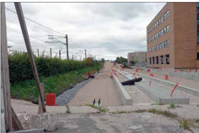
Ned till Glostrup Station byggs ett dubbelspårigt stickspår från Søndre Ringvei i bakgrunden, för att skapa goda bytsemöjligheter till S-banen.
