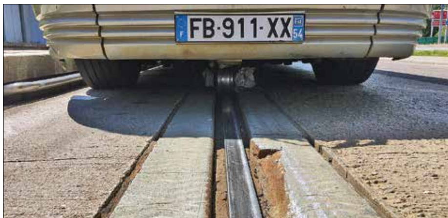
Bilden visar dubbelflänsat styrhjul av minimal storlek samt styrskena. Notera slitage av skena och omgivande markområde. TVR-systemet hade knappast kunnat vara i drift mycket längre. Foto, samtliga, där ej annat anges: Nils Zimmermann
