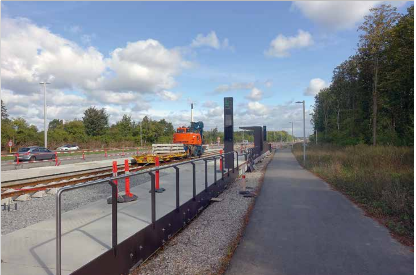
Här vid Glostrup Ejby byggs en provhållplats för den kommande spårvägen i Köpenhamn. Linjen blir 28 kilometer lång och får 29 hållplatser. Den går mellan Lyngby i norr och Ishøj i söder. För trafiken levererar Siemens 29 stycken spårvagnar av typen Avenio i längd omkring 37 meter och bredd 2,65 meter. På sex hållplatser blir det möjligt att byta till S-tog: Lyngby, Buddinge, Herlev, Glostrup, Vallensbæk och Ishøj.
