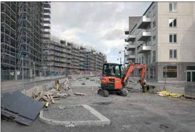
På Kavallerivägen får spårvägen grässpår i mittläge, här med hel betongplatta som underlag. På vissa avsnitt läggs grässpåret i stället på längsgående betongbalkar. Många nya bostadshus kantar gatan.
