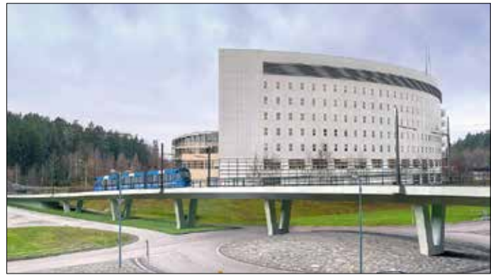
Visionsbild av spårvägsbron över Enköpingsvägen med cirkulationsplats. Detta blir en brant passage på Tvärbanans Kistagren: 6 procents lutning. Visionsbild: Trafikförvaltningen/Treeline
