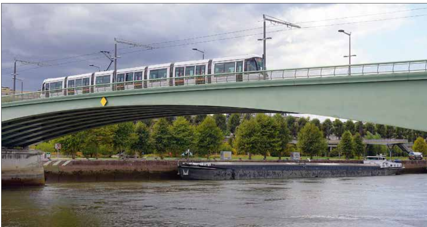
De båda spårvägslinjerna i Rouen passerar på reserverat utrymme på bron Pont Jeanne d'Arc över Seine. På bilden framgår spårvagnarnas rejäla längd, 44 meter.
