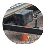
Isolering av avvattningsslådor och spårhållare
