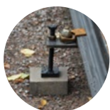
Rälsjustering i höjd och sidled
