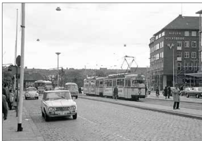
Vid spårväghållplatsen vid centralstationen i augusti 1966. Två motorvagnar i multipeldrift anländer.
