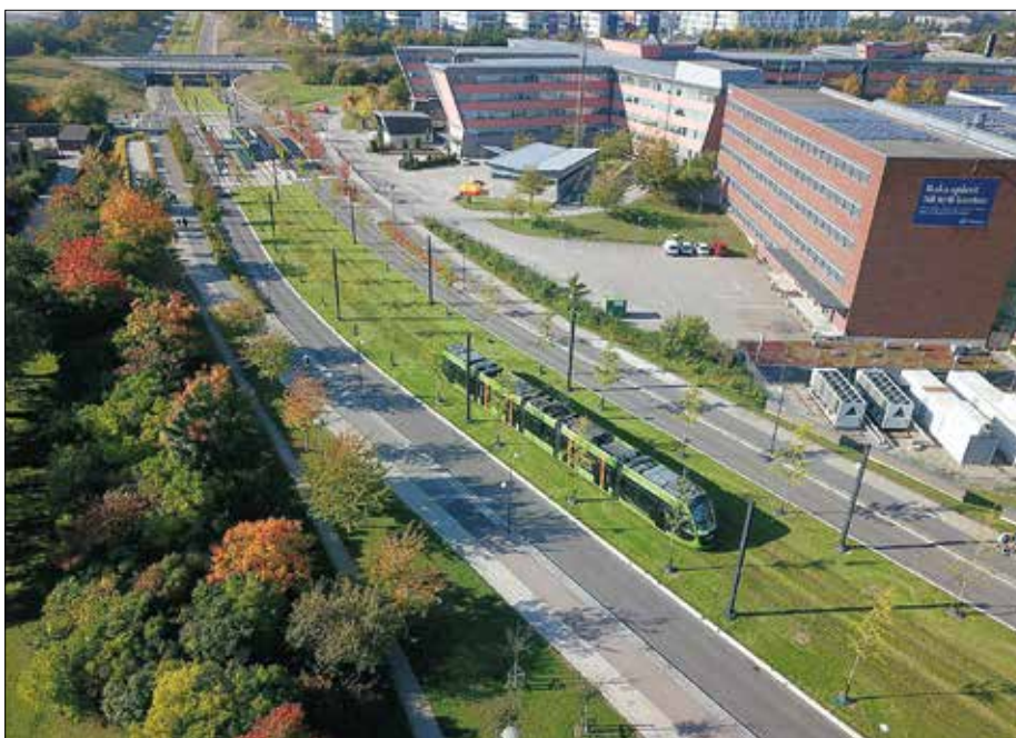
För att säkerställa en öppen utformning av spårvägsanläggningen gestaltades denna med en vit linje som består av en 30 cm bred vit granitsten som löper längs med ytterkanterna av spårområdet på vardera sidan. Linjen syns tydligt på denna flygbild. Foto: PG Andersson
