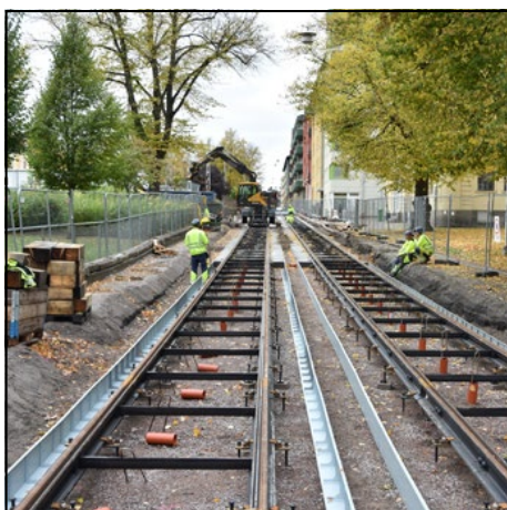
Rälsjustering i höjd och sidled
