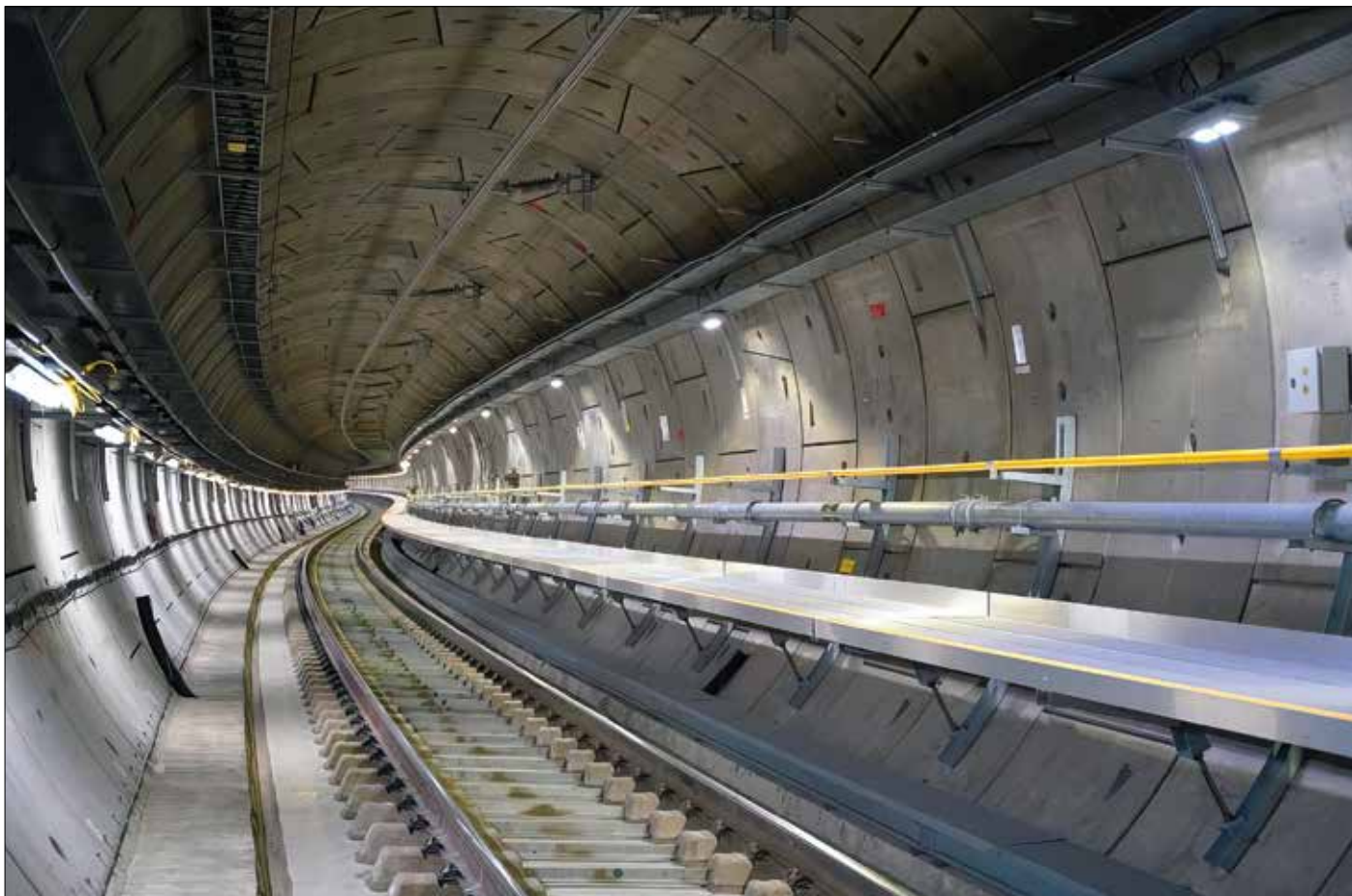
Så snart tunneln var klar påbörjades spårläggningen på betongspår (Slab Track). Detta genomfördes med en maskin som hade utvecklats av de franska företagen TSO, Metalliance och Novium. Montering av kontaktskenor i stället för kontaktledningar gjordes av ATC-konsortiet (Alstom-TSO-Costain) och installeringen av CBTC-säkerhetssystemet av konsortiet Siemens-Invensys. Foto: Siemens
