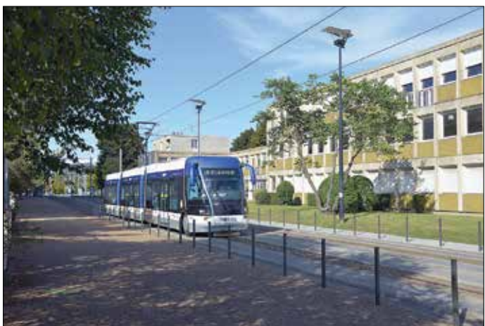
Vid Campus 2, den norra ändhållplatsen för linje TVR A, gick bussarna centralt i området.
