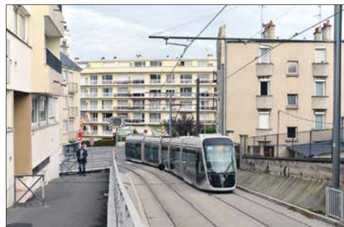
Lutningen söder om stationen har fått justeras för spårvägen. Den är fortsatt kraftig (6-7 procent) men inte samma som för TVR. Gatan har sänkts vilket som synes har påverkat omgivande gaturum.
