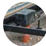
Isolering av avvattningslådor och spårhållare
