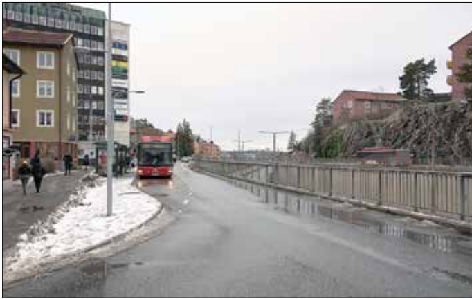
Busshållplatsen Torsviks torg ligger som på en hylla mellan bebyggelsen och den djupt förlagda, motorvägslänkande Södra Kungsvägen. I om- dragningsalternativet med bro och ramp skulle banan passera här.
