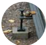
Rälsjustering i höjd och sidled
