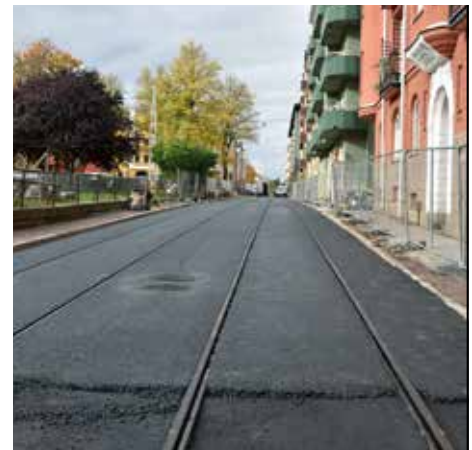
Isolering av avvattningslådor och spårhållare
