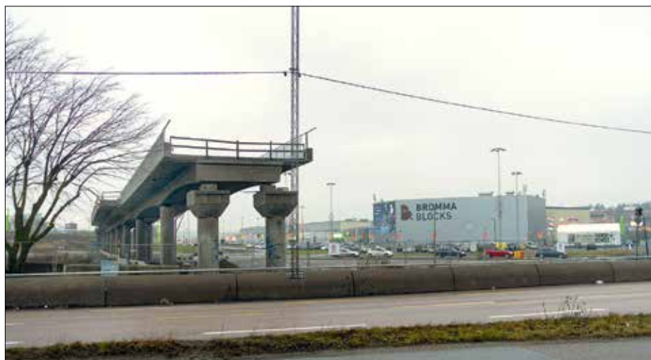
Det gäller att snabbt få nytta av gjorda infrastrukturinvesteringar, inte låta konstruktioner stå oanvända under längre tid.
