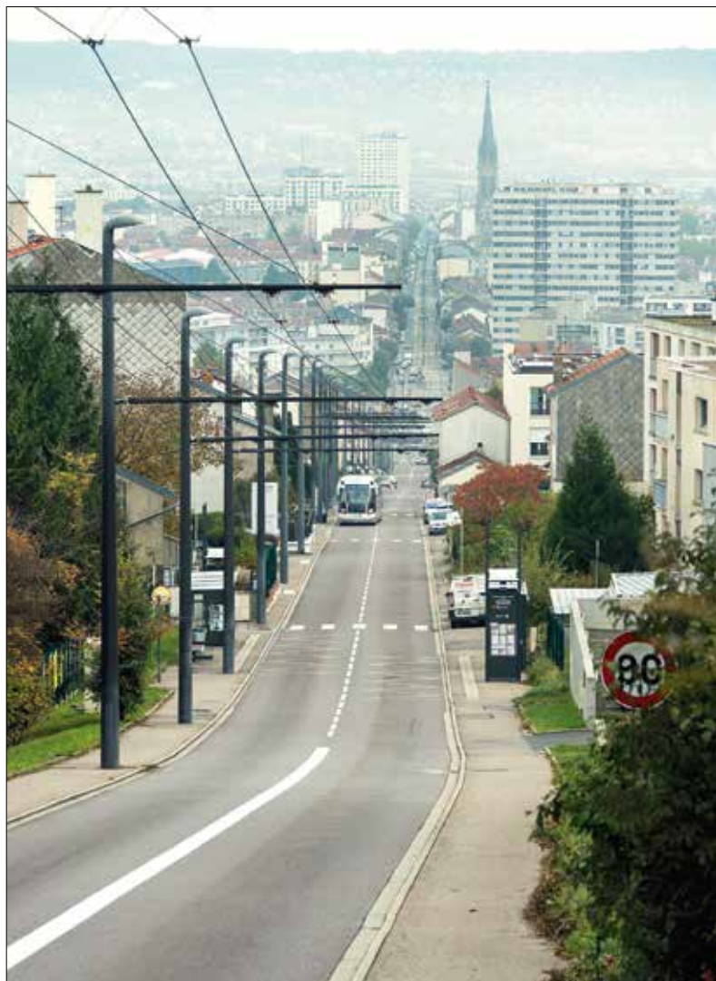
Staden Nancy ligger i en gryta med omgivande höjdsträckningar. För andra gången i trafikhistorien har backen upp mot området Brabois stoppat ett spårvägsprojekt. De planerade alternativa uppfartsstråken blev för dyra.
