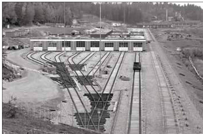
Under den aktuella tioårsperioden 1963–1973 började bland annat tunnelbanan byggas ut till Järvfältet och Botkyrka. På bilden är Rissnehallen under byggnad under 1970-talet. Idag byggs Tvärbanans Kistagren i skogsslätten i bakgrunden.
