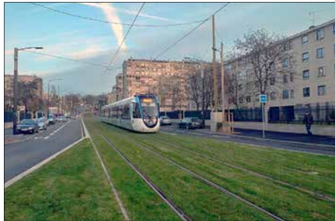
Det tog 13 år att bygga en 4,7 kilometers förlängning av linje T4, på gatan, med spårvägsstandard, till Montfermeil, som naturligtvis inte har någon kontakt med andra spårvägslinjer. Foto: Gilbert Lafarge
