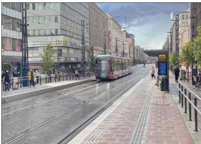
Väl utrustad spårväghållplats med bland annat väntkur och passagerarinformation. Busstrafiken har en egen hållplats längre bort utmed gatan, med plattformshöjd som är anpassad för bussar.
