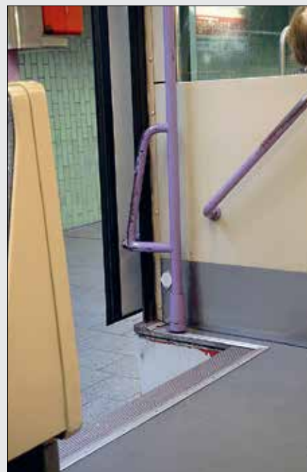
...svårt att röra sig. Till vänster stängd dörr och uppfällda fotsteg, till höger öppen dörr vid låg plattform och nedfällda fotsteg. En tämligen komplicerad lösning.
