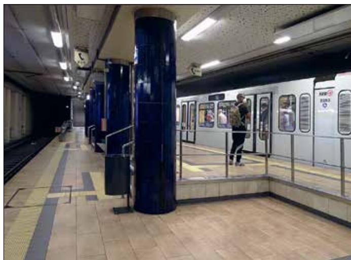
Station med skilda plattformshöjder och trappor mellan nivåerna. Till höger stannar just en B-vagn, med högt golv.
