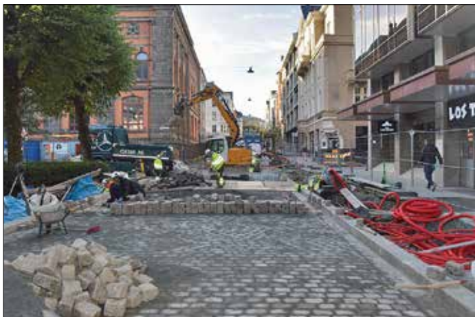
Också i Bergens centrum pågår stora gatuarbeten som här på Olav Kyrresgate, där trådbussarna går över i batteridriften efter att ha lämnat den befintliga trådsträckan.
