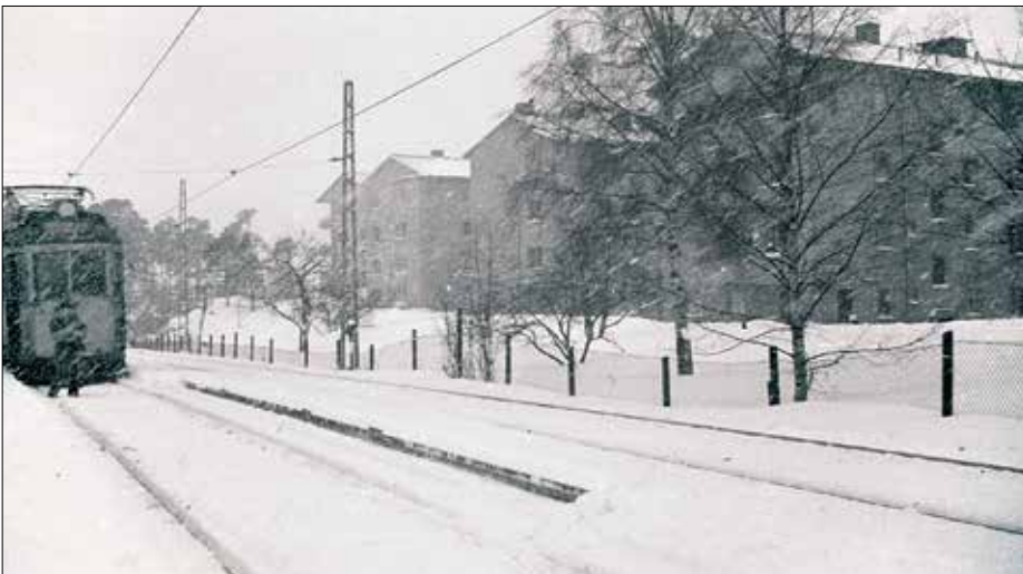
Problem med strömskena och stockholmskt vinterväder är inte nytt. Redan runt 1950 fick SS anledning att oroa sig över strömförsörjningen på provsträckan för den kommande tunnelbanan, här mellan dåvarande spårväghållplatserna Johanneshov och Slakthuset, med översnöad strömskena.
