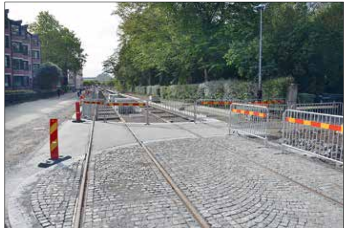
I mitten av september lades den första ytan med gatsten i St Laurentiigatan. Denna del av spårvägen får en fast bana för att det ska vara möjligt att köra buss i en framtid. Övriga sträckor får grässpår utom i korsningar och vid hållplatser.
