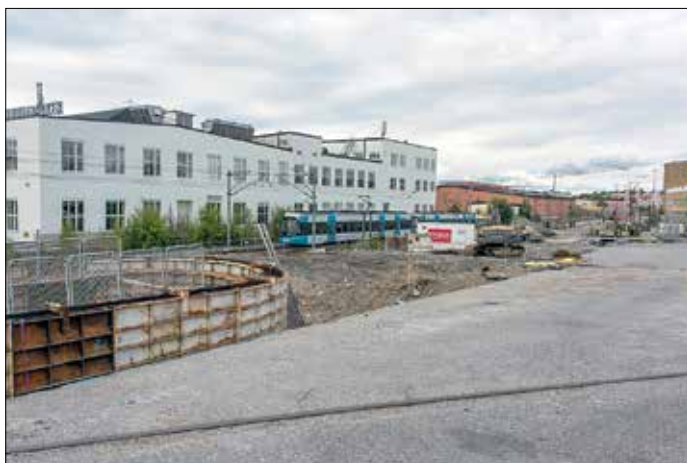
I början på året inleddes även arbeten med ledningsomläggningar vid Bromma flygplats och strax därefter har arbeten här vid blivande förgreningshållplatsen Norra Ulvsunda påbörjats.
