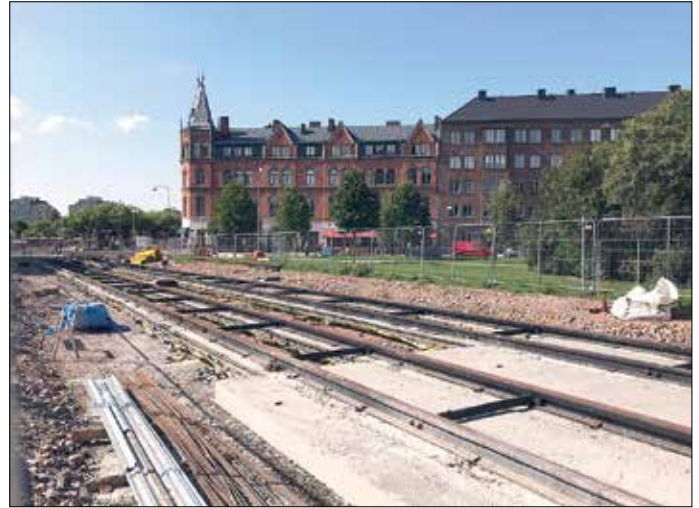
Arbetena i St Laurentiigatan går framåt och i början av september hade nästan hela gatan gjutits. Här blir det betong mellan rälna. Betongen utgör sedan underlag för gatstenen som spåret senare ska bäddas in i.
