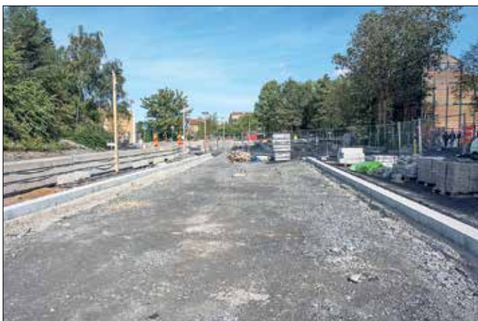
I Kavallerivägen i Rissne pågår stora ledningsomläggningar och de första avsnitten av den nya spårvägen börjar skönjas. Här blir det gräs-spår, avgränsat till omgivande körbanor med en vit så kallad ramsten, som nu finns på plats på vissa avsnitt. Jämför den vita linjen vid nya spårvägen i Lund. På bilden syns ramstenen på ömse sidor om den blivande spårvägen. Spår och gräs dröjer ännu en tid.
