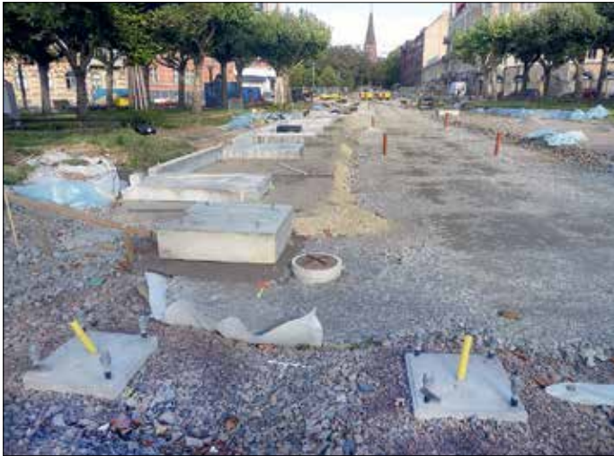
Vid Clemenstorget pågår arbeten med de kommande plattformarna. I förgrunden ses fundamenten till de avslutande kontaktledningsstolparna. Växelkrysset som ska ligga i den nordöstra delen av torget beräknas till Lund i november. Montering kommer sedan att ske när vädret tillåter.
