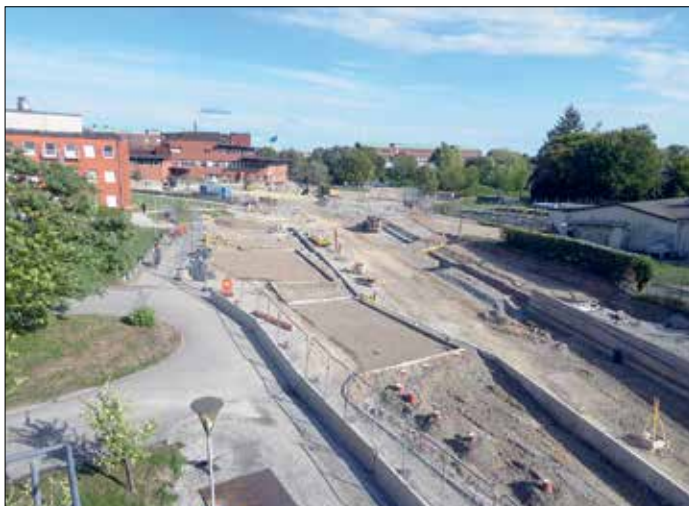
Vid LTH görs plats för en 80 meter lång hållplats vilket gör att kurvan får en snävare radie än den tidigare bussvägen Lundalänken. Bilden visar läget i slutet av augusti.
