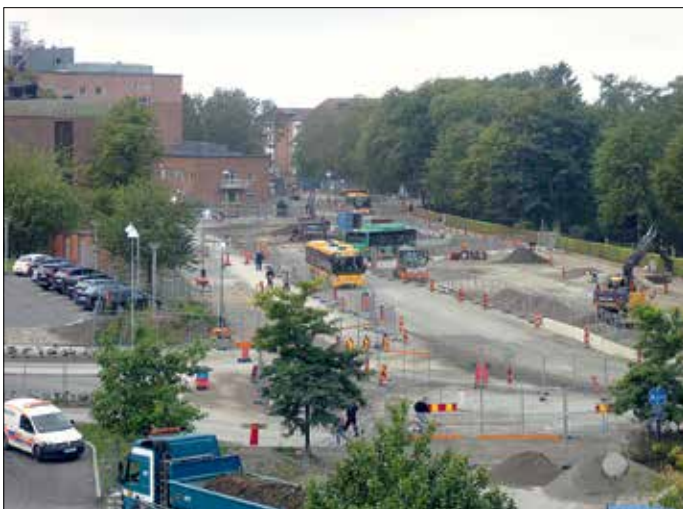
Vid Universitetssjukhuset har den forna storhållplatsen för bussar helt utplånats. Busstrafiken snirklar sig genom byggarbetsplatsen på vägar som ändras med jämna mellanrum. Ofta finns delsträckor där bussarna inte kan mötas vilket regleras med siktkörning.
