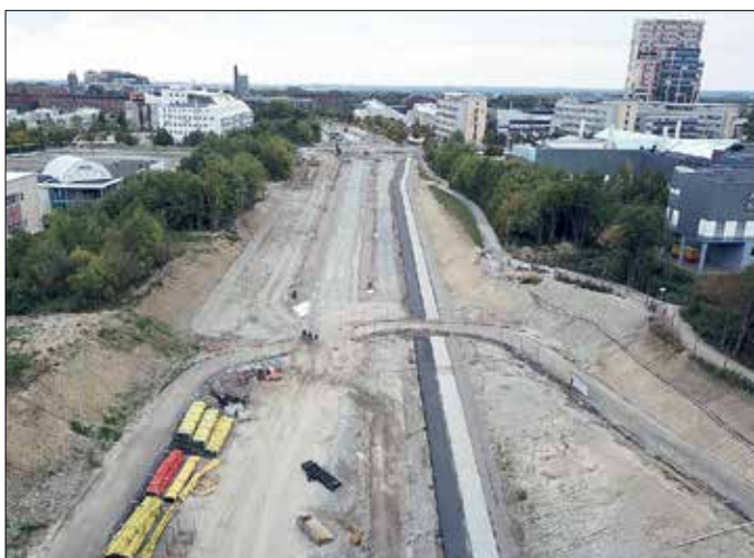
Arbetena med Sölvegatan väster om motorväg E22 går framåt och på bilden från mitten av september ser vi hur gång- och cykelvägen växer fram. På denna sträcka blir spårvägen placerad mitt i gatan.
