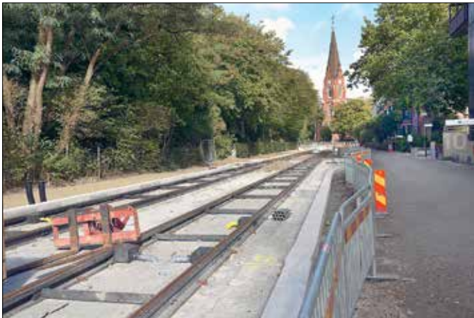
St Laurentiigatan mot Allhelgonakyrkan. Vi ser tydligt den vita linjen som ska inrama hela spårvägen från Clemenstorget till ESS. En bit bort i bilden kan även en breddning av vita linjen anses vid den fotgängarpassage som ska ligga mellan Clemenstorget och Allhelgonakyrkan.
