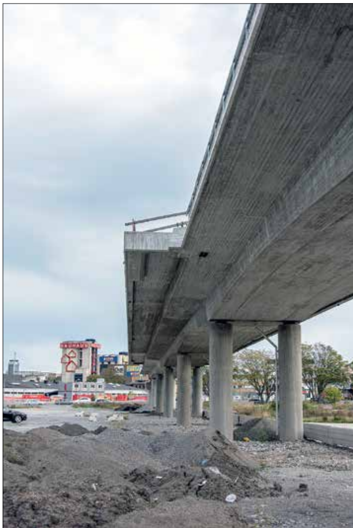
Delar av den långa spårvägsbron vid Bromma Blocks har stått färdig i råkonstruktion i mer än ett år.
