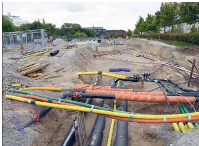
Det blivande Ideontorget sett från öster mot väster. På denna sträcka i Sölvegatan har det flyttats många stora ledningar och bilden visar att det som kommer att finnas under spåren är en ganska komplex värld av olika typer av ledningar. Strax väster om hållplats Ideontorget kommer en övergångsväxel att läggas in.
