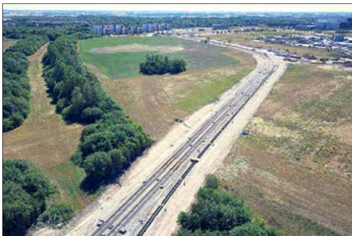
Vi blickar åt sydväst från en punkt ovanför den blivande hållplatsen MAX IV i mitten av juli. Spårläggningen var i mitten av september klar på denna sträcka som nu väntar på bebyggelse.
