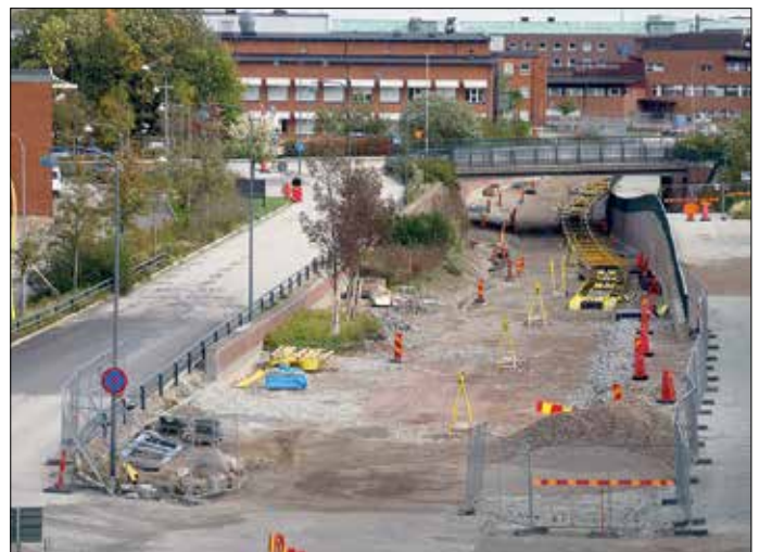
I slutet av september pågår spårläggning vid passagen under Tornavägen. Detta är en av de sträckor som ska förses med särskild kontaktledning för att minska de elektromagnetiska störningarna från spårvägen.
