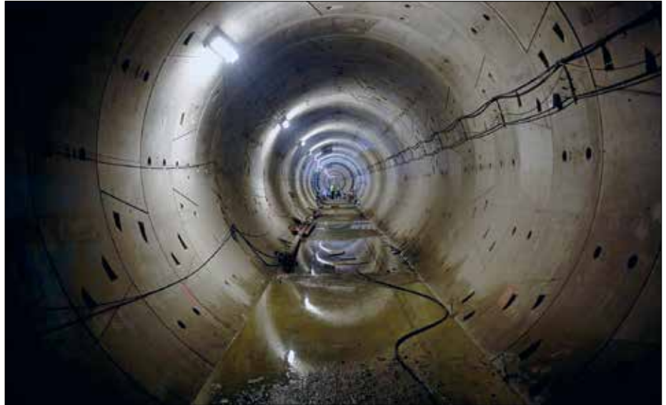
Tunneln är här klar för spårläggning.
