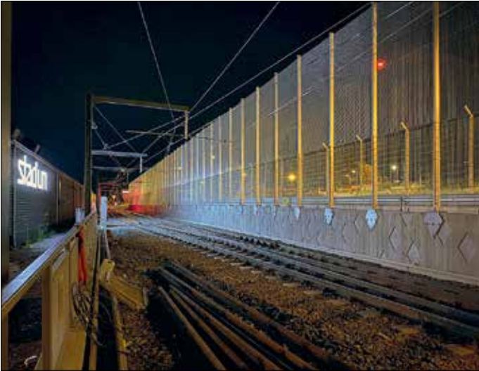
Bild från provkörningen den 24 juli med fjäderväxeln för övergång från dubbel- till enkelspår till höger. Det höga metallstaketet för avskärmning av möjliga störningar från spårvägens kontaktledning syns tydligt.
