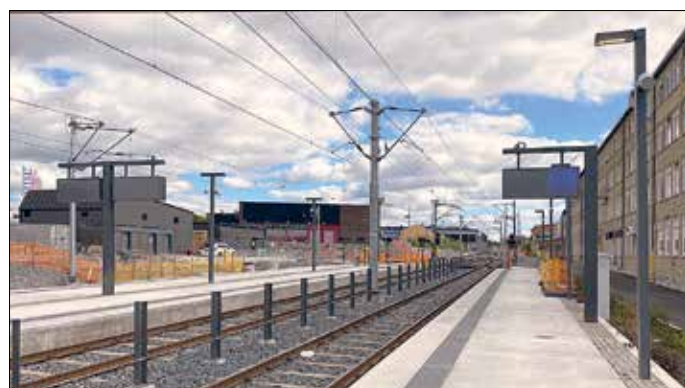
Norra Ulvsunda återöppnades den 1 augusti. Dock var hållplatsen då ännu inte helt färdig utan alltjämt delvis en byggarbetsplats. Foto: Martin Lindahl
