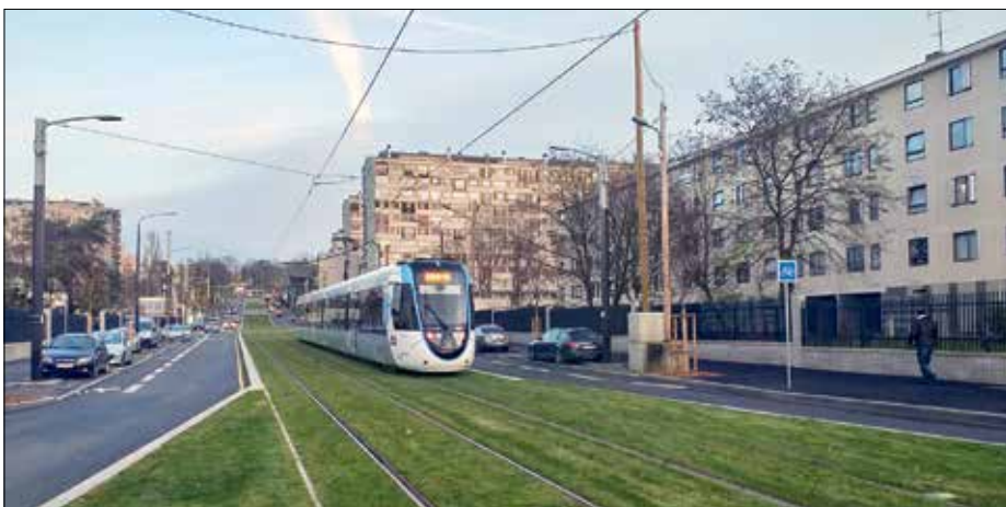
Nya sträckan på linje T4, grenen mot Montfermeil, mellan Maurice Audin och Mairie de Clichy. Notera grässpår mitt i bred gata, med begränsat utrymme för biltrafiken. Foto: Gilbert Lafargue
