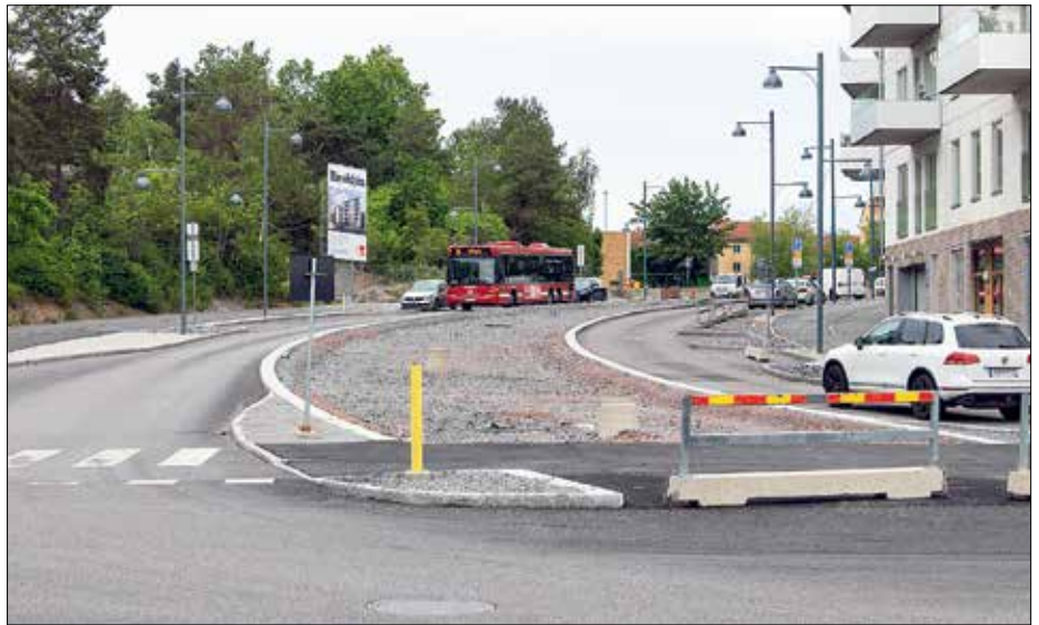
I Kavallerivägen i Rissne har den kommande spårvägens utrymme i gatumitt varit i det närmaste färdigställt en längre tid. Den vita ramstenen avgränsar det blivande spårområdet.
