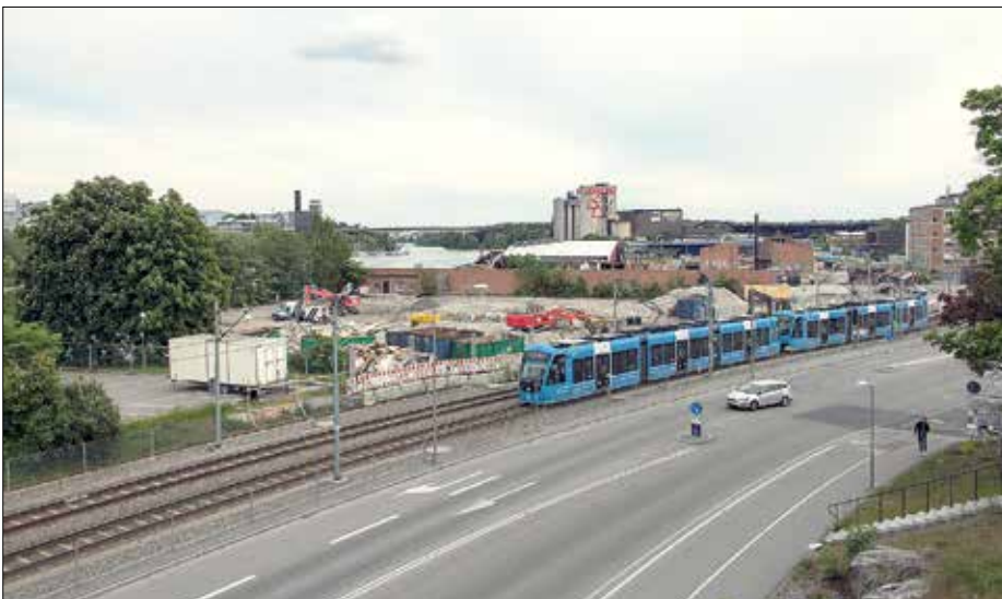
Tillbaka till Solnagrenen: Utmed Karlsbodavägen rivs nu industrifastigheter inför ny bostadsbebyggelse. Också området intill Norra Ulvsunda kommer att radikalt omdanas.
