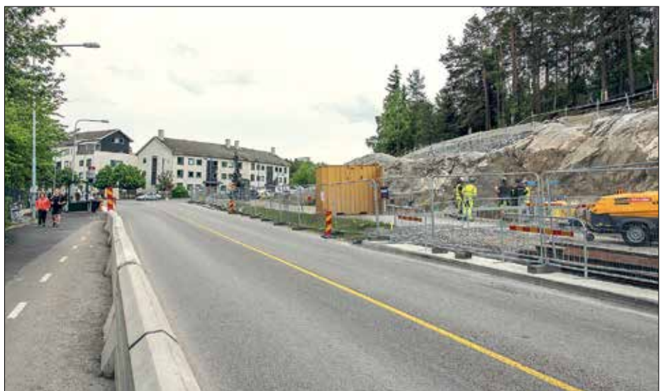
Artillerivägen med Rissne centrum bortom kurvan till höger i fonden. Spårvägen anläggs i den högra vägkanten, där bergschakt utförs. Här intill passerar spårvägen över tunnelbanans tunnlar vilka ligger ytligt. Det begränsade vertikala utrymmet gör att lågprofilräl måste användas.
