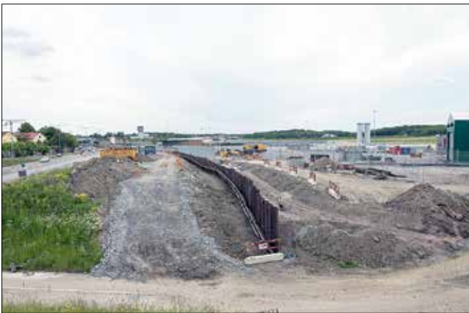
Schaktarbeten utmed Ulvsundavägen, nära flygplatsgränsen, intill korsningen med Bällstavägen.
