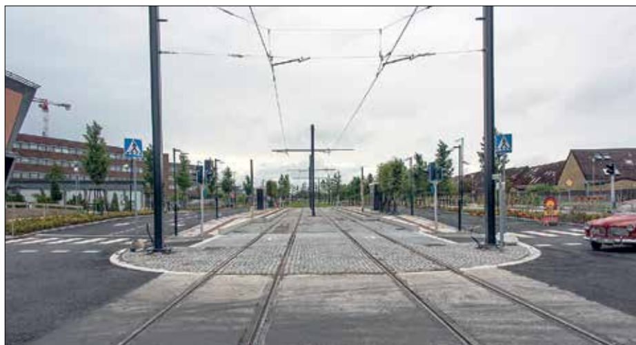
Hållplats Telefonplan, med smågatsten i spårområdet och markbeläggning i avvikande färg på körbanan närmast.
