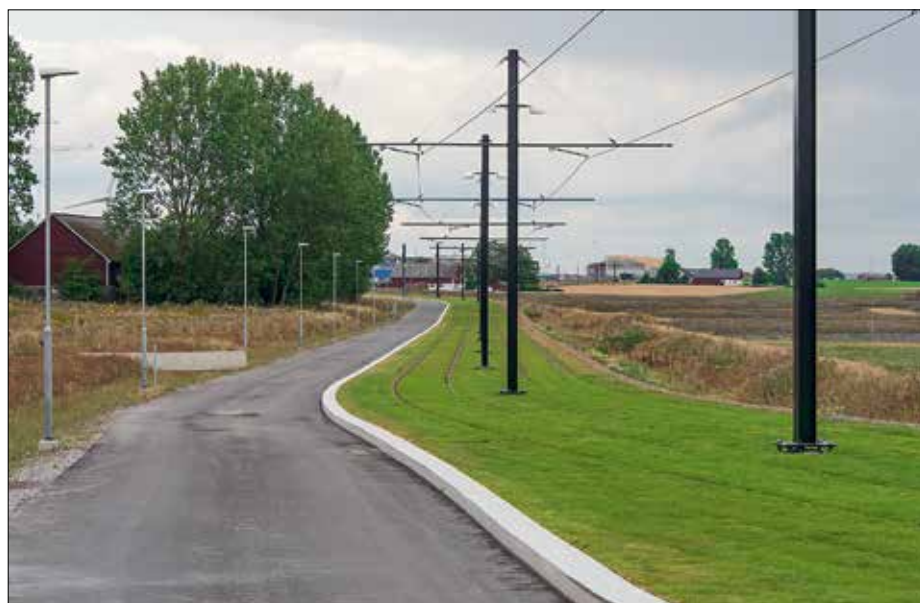
En grön spårväg på skånska landsbygden, med åker och äng tätt inpå. Gång- och cykelväg löper i princip parallellt med spårvägen på hela sträckan. Den tjänar även som räddningsväg.
