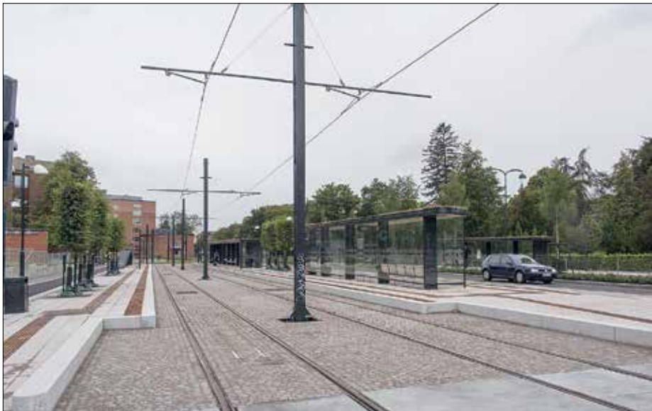
Vid universitetssjukhuset har busshållplatsen åter öppnat, längst till höger i bild. I spårvägsspår framförs inga bussar. Dessa hållplatser har helt nya typer av väderskydd, unika för Lund.
