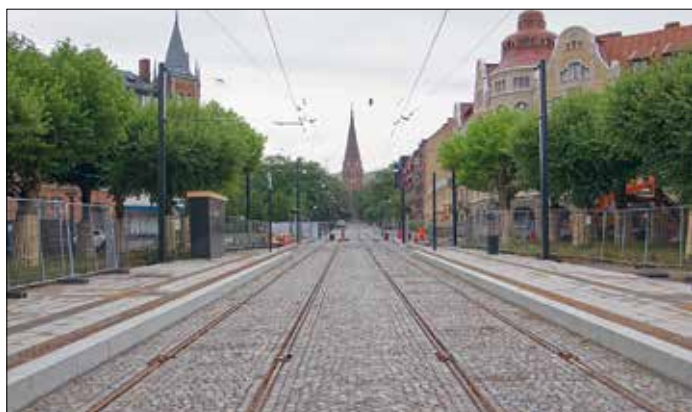
Ändhållplatsen Lund C med smågatsten i spårområdet. I förgrunden de mekaniska hjulstoppen som hindrar spårvagnar att köra för nära den stenbärräi som avslutar spårområdet strax utanför nedre bildkant.
