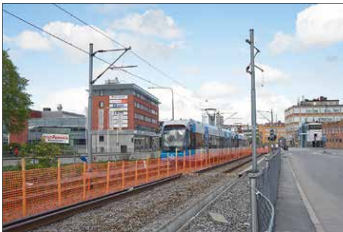
Ombyggnad av hållplats Norra Ulvsunda pågår sedan våren 2019 och leder till enkelspårstrafik. Spårvagnarna stannar inte vid Norra Ulvsunda och Karlsbodavägen.
