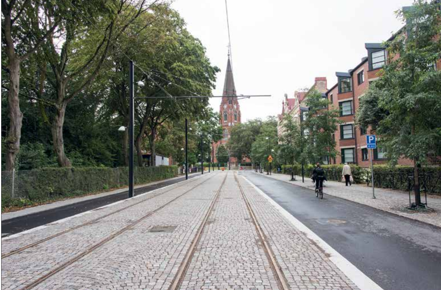
St Laurentiigatan sedd mot Allhelgonakyrkan, med prydligt satt smågatsten och den breda vita linjen som avgränsar spårområdet. Stolpar och kontaktledning är också på plats. Biltrafikutrymmet är reducerat till ett minimum.
