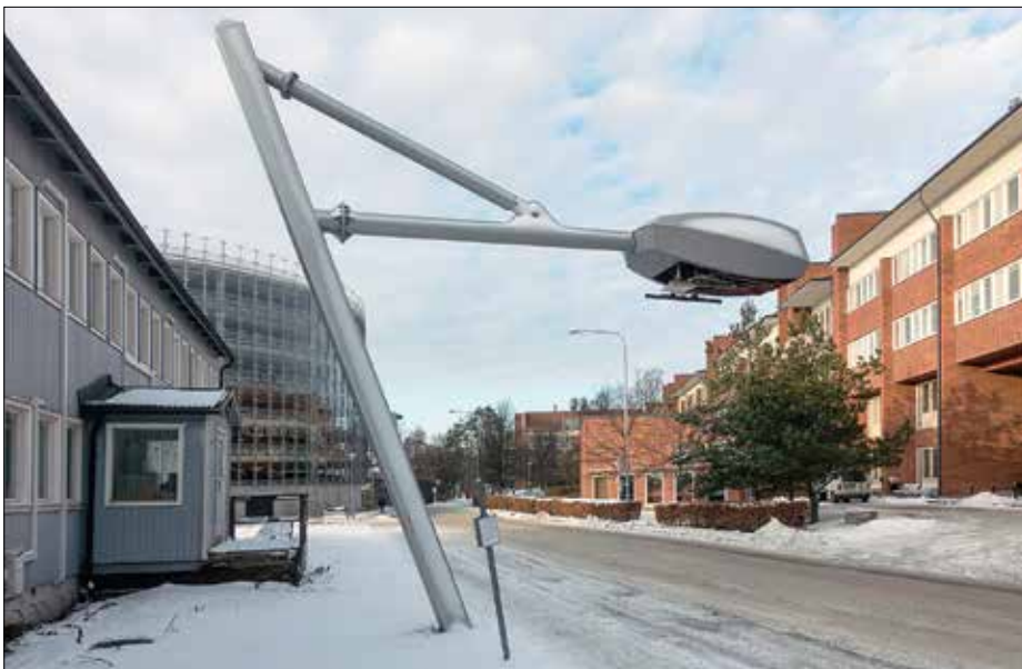
Långt senare kunde laddanordningen vid Karolinska institutet också komma på plats. Efter nedläggningen av linje 73 är hållplatsområdet helt oanvänt. Laddanordningarna är tämligen dominerande i gatubilden.
