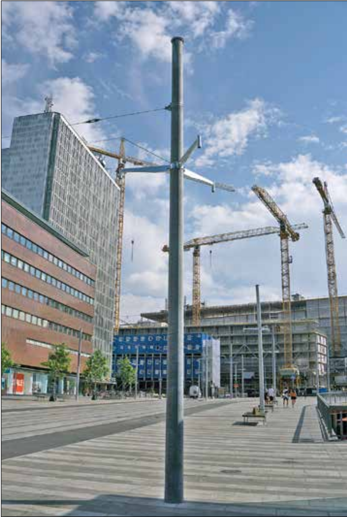
Fästen för gatubelysning är monterad på kontaktledningsstolparna.
