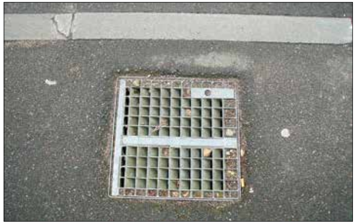
I Tours kan man se många välgenomtänkta detaljer, både i spårvägen och annars. Här ett dagvattengaller där de snedställda lamellerna stoppar klacken från att gå igenom. Denna typ av omtanke om användarna är typisk för franska spårvägars utformning.
