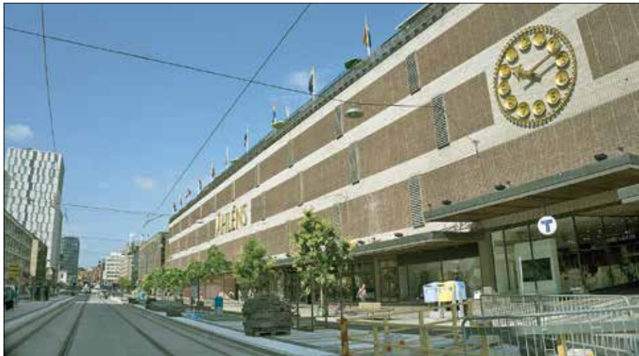
Klarabergsgatan med Åhléns varuhus vars fasad används för infästning av kontaktledningen.
