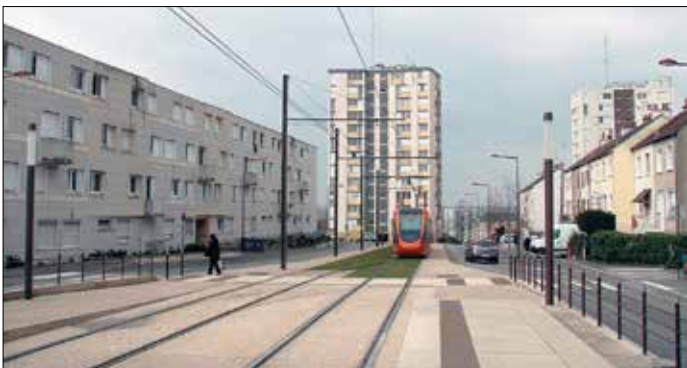
Bilden visar en mycket vanlig situation vid de franska spårvägarna: ändhållplats med övergångsväxlar. Med tvåriktningvagnar kan vändning även göras vid övergångsväxlar på linjen, exempelvis vid trafik hinder. Ändhållplats Bellevue – Hauts de Coulaines i Le Mans.
