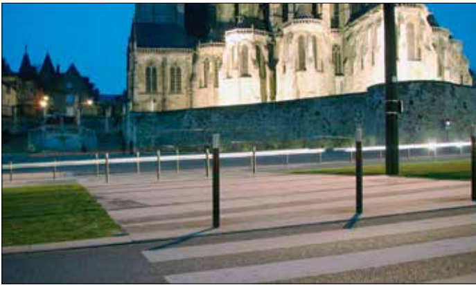
Nattbild av spårövergång på Avenue de Paderborn i Le Mans. Enkel layout med fokus på användaren. Observera att pollarna står mot bilvägen, inte mot spåret! I bakgrunden Cathédrale Saint Julien som byggdes under 1000- till 1300-talet.
