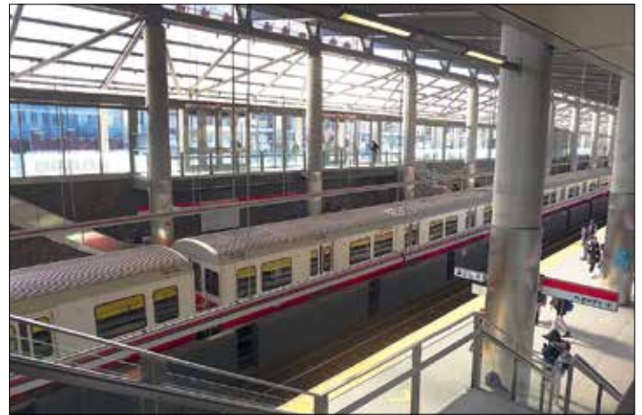
Tunnelbanestationen i Ashmont, sedd från spårvägens plan. Tunnelbanevagnarna är klassiska, men kommer inom kort att ersättas med en ny, modern generation vagnar.
