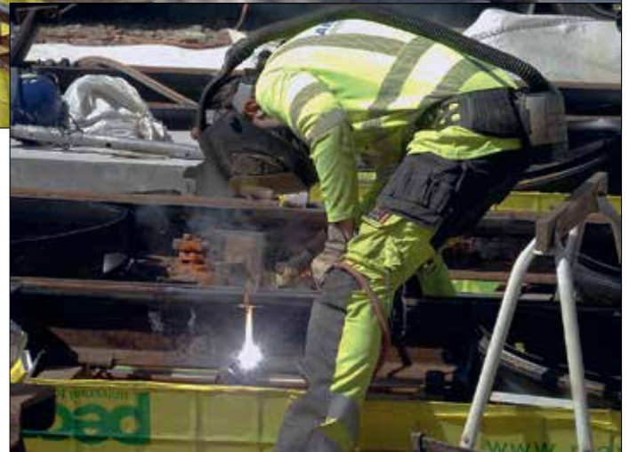
Svetsning av en av skarvarna där isoleringen på rälen vikts undan för att inte skadas av värmen.
