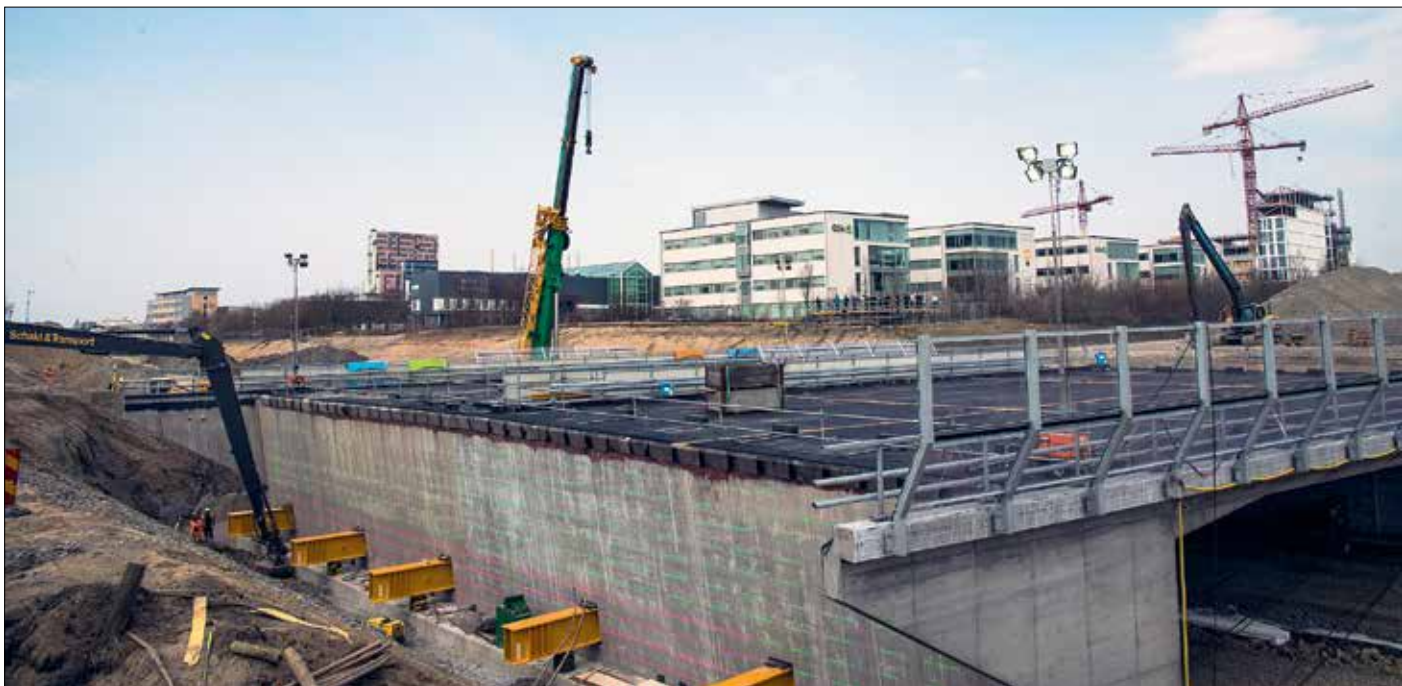
Den färdiga bron är på plats. Nu återstår fyllnad runt omkring bron.
