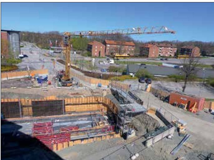
Längs Baravägen på sjukhusområdet pågår arbeten med de kulvertar som sjukhuset ska bygga innan spårvägsarbetena kan ta över platsen.
