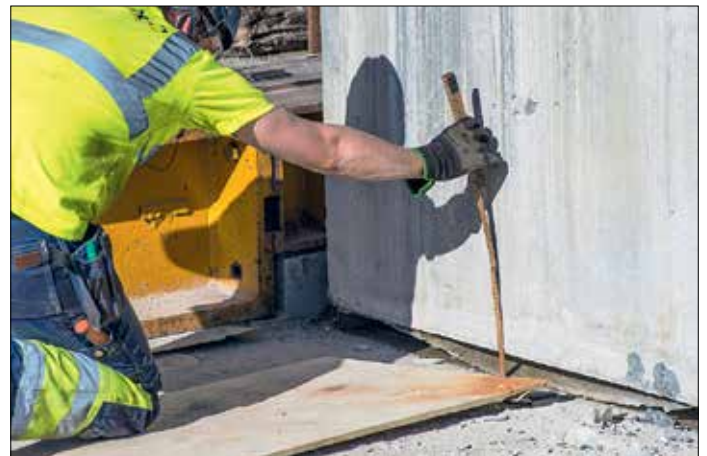
Bron har lyft! Det är inte många centimeter som behövs för att bron ska kunna röra på sig.
