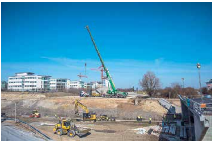
För att bron skulle kunna flyttas cirka 65 meter behövde markytan vara helt plan.
