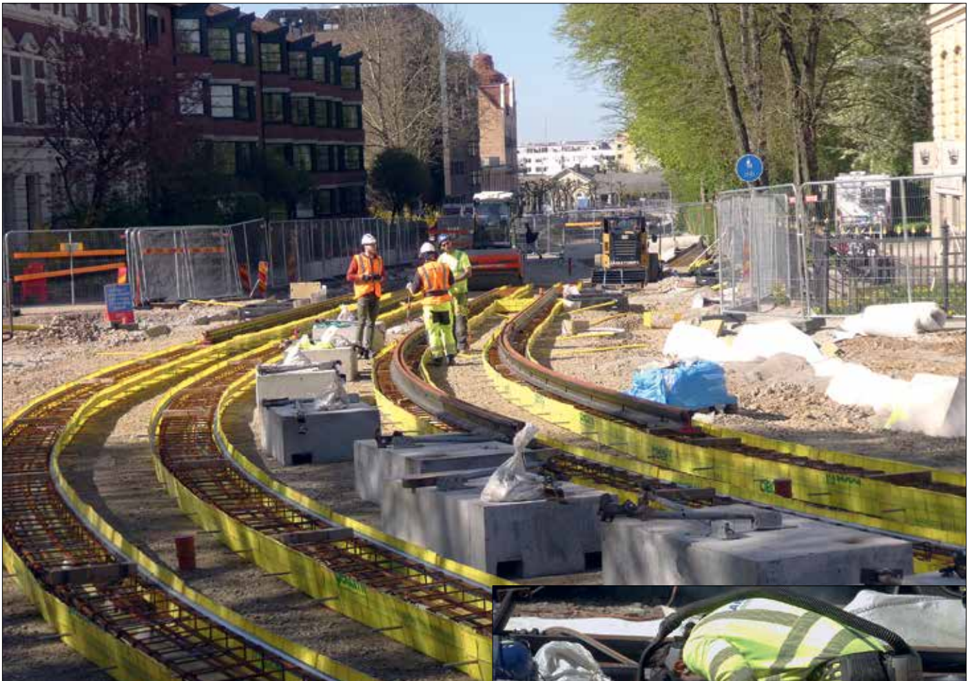
Efter omkring en timmes arbete är fyra raka räler och två kurvräler på plats i kurvan vid Allhelgonakyrkan.
