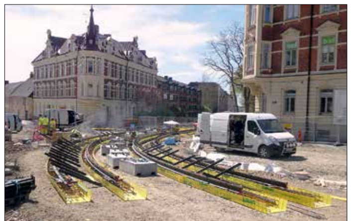
Hela kurvan ligger på plats och arbete med svetsning och montering av spårhållare pågår för fullt runt fyra timmar efter att den första rälen har lyfts av från lastbilen.
