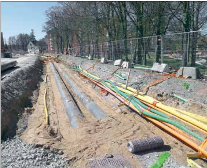
I södra delen av Getingevägen pågår omfattande ledningsarbeten. Man slås av färgprakten i gropan.
