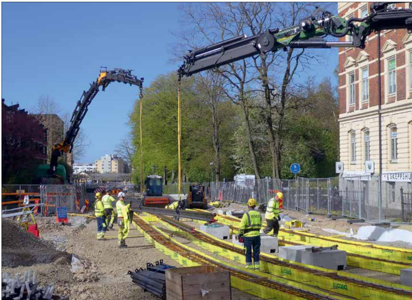
Den första rälen placeras i rätt läge på lördagsförmiddagen den 5 maj med hjälp av noggranna händer från medarbetare vid Anker Spårteknik.
