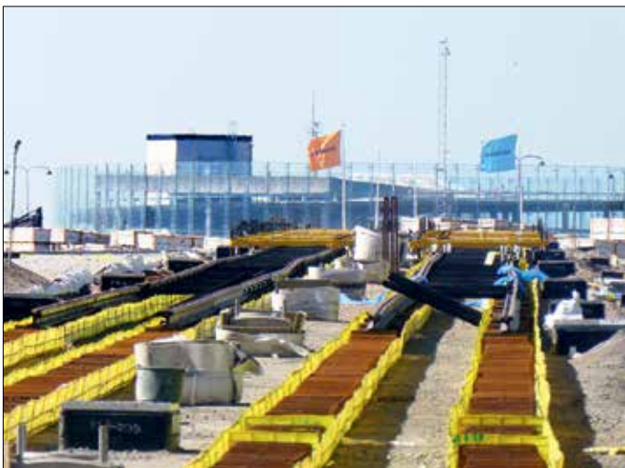
Den 21 april 2018 hade spårläggningen nått fram till den blivande korsningen med Utmarksvägen, där hållplats Max IV ska ligga.
