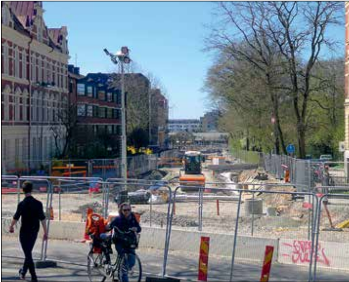
I St Laurentigatan har återställningen av gatan påbörjats och markdukarna som ska förhindra vibrationer syns under bärlagret.
