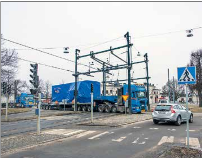
Inför passage av höga lastbilstransporter från Siemens Industrial Turbo-machinery AB i Finspång hissas kontaktledningen upp och transporten kan passera utan dröjsmål.
