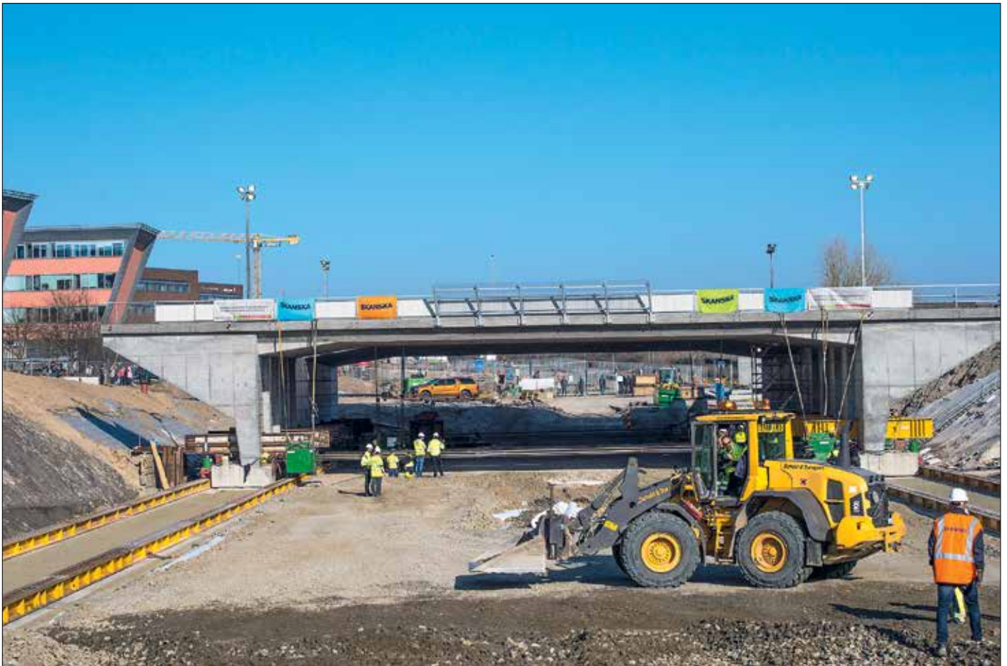
Motorvägsbron görs redo för att flyttas på plats.
