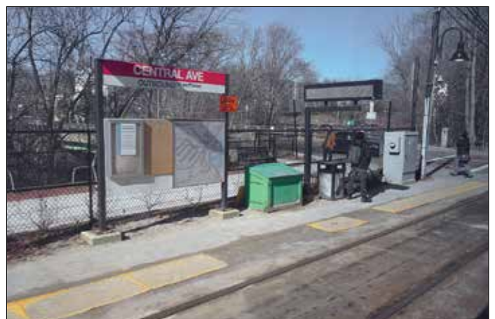
Typiskt sparsam hållplatsutformning på Mattapanlinjen. Det finns inte ens refuger. Påstigning sker från gatunivån! Rörelsehindrade klarar sig dock, ty vid alla hållplatser finns det ramper och lyftanordningar som garanterar att den som inte mår med PCC-vagnens många trappsteg ändå kommer ombord. Det är bökigt och tar tid, men alla kommer med.
