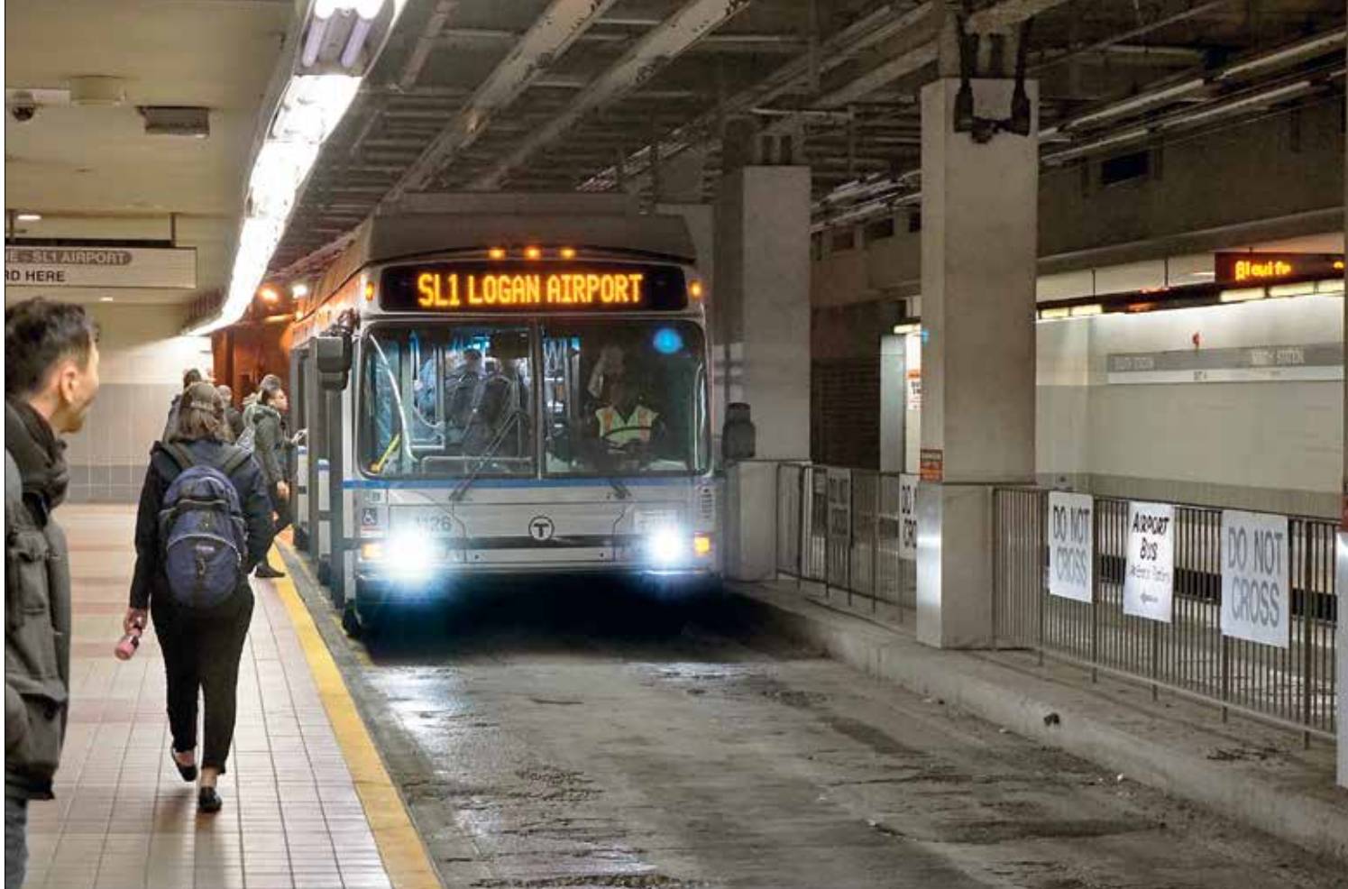
Bild från busstunneln i Boston. Tunneln trafikeras bland annat av duobussar på linje SL 1 (Silver Line) på sträckan mellan flygplatsen och South Station. Större delen av linjen körs med dieseldrift, men på den sista delsträckan fälls spröten upp och bussarna går som trådbuss på en underjordisk del med stationer. Bilden visar påstigningshållplatsen under South Station, en hållplats SL1 delar med ytterligare två duobusslinjer.
