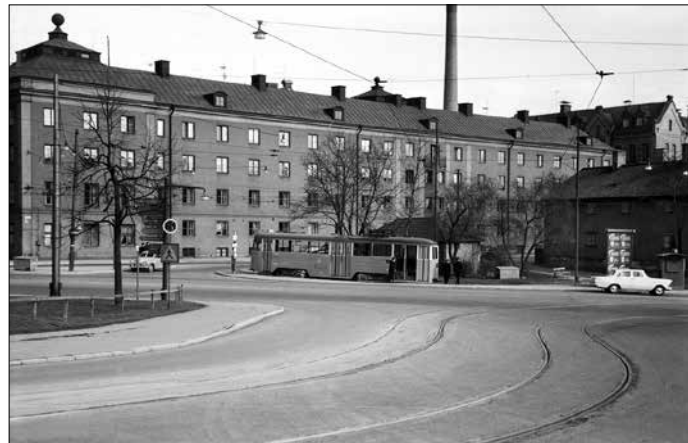
Rosenlund i mars 1964 med en spårvagn på linje 1 i vändslingan, närmast leder spåren upp till Södersjukhuset som trafikerades av spårvägslinje 8. Idag trafikerar stombusslinje 3 inte obetydliga delar av dessa forna spårvägssträckningar.
