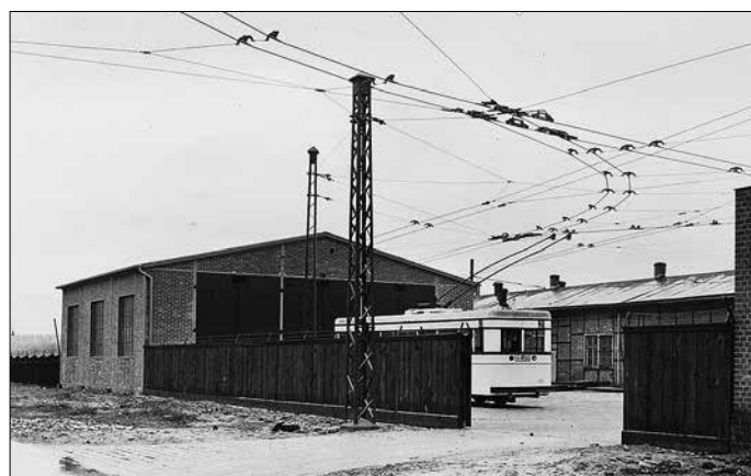
Depå för trådbussarna i Spandau 1933, Pichelsdorfer Straße, med tre kontaktlednings-"spår" i hallen, de två yttre utan direktanslutning. Bussarna backades ut och vändes i en lednings-"triangel". Fabriksfoton
