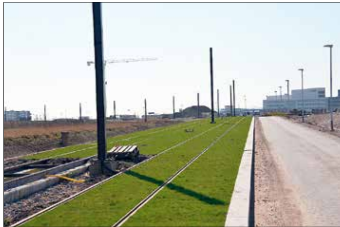
I månadsskiftet februari-mars 2019 började kontaktledningsstolparna att sättas ut, totalt 282 stycken, de flesta individuellt utformade.
