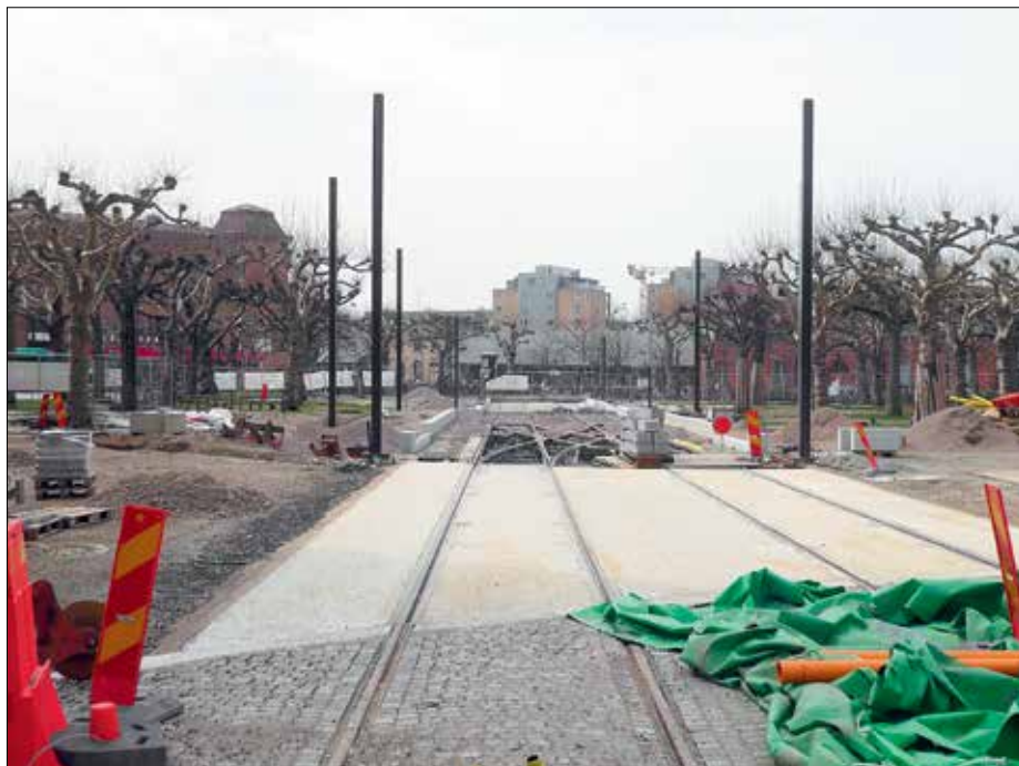
Den 13 november 2018 anlände de första delarna till spårvägens kryssväxel på Clemenstorget. Växeln levereras i delar, eftersom hela komplexet inte får plats att transporteras i ett stycke. Bilden visar växelaneläggningen på Clemenstorget i början av april 2019.
