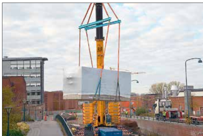
Likriktaren vid sjukhusområdet lyfts på plats den 4 oktober 2018. Totalt finns fem likriktare längs spårvägen. All inkommande 10,5 kV tas in vid likriktaren vid MAX IV varefter spårvägen har ett eget 10 kV-nät för matning av övriga likriktarstationer.
