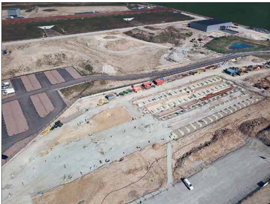
Den 20 december 2018 meddelades att regionstyrelsen i Region Skåne hade beslutat att tilldela NCC Sverige AB ansvaret för den andra byggetappen (byggnaden) vid spårvagnsdepån.
