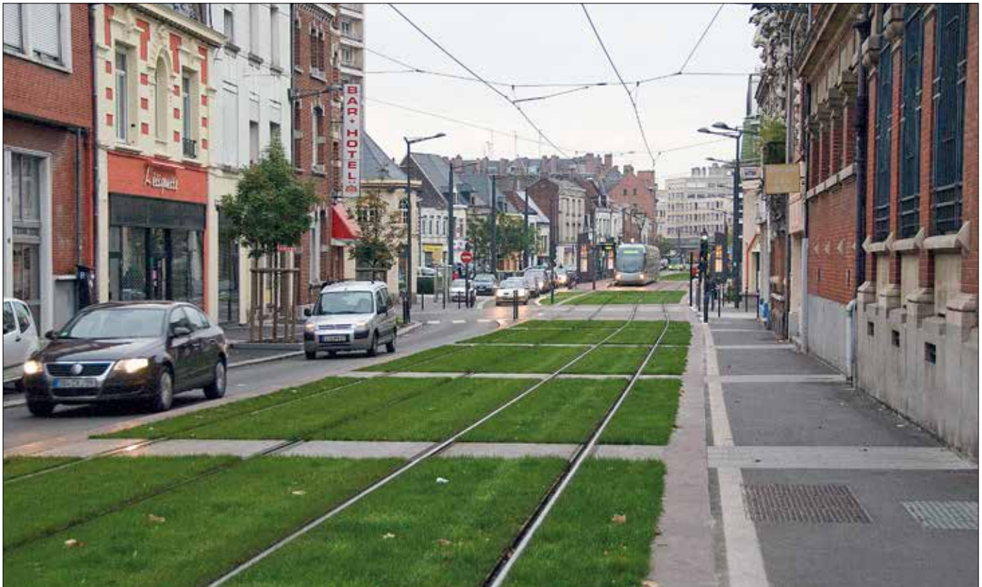
Några temaexempel ur VTI-rapporten: Grässpår är ett tydligt sätt att visa att denna del av gatan är reserverad för spårvagnar; ett led i strävan att skapa tydliga trafikmiljöer. Detta är självklart för den moderna spårvägen och väcker ökad acceptans vid ombyggnad av klassiska system. Bild från Valenciennes i norra Frankrike. Notera även att där hus finns intill spåret så fästs kontaktledningens tvärspann i husväggarna. Stolpar förekommer endast där lämpliga husväggar saknas.
