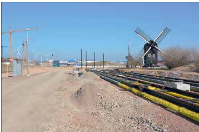
Den blivande ändhållplatsen ESS i slutet av mars 2019. Det vänstra spåret går vidare som enkelspår mot depån medan det högra slutar här.
