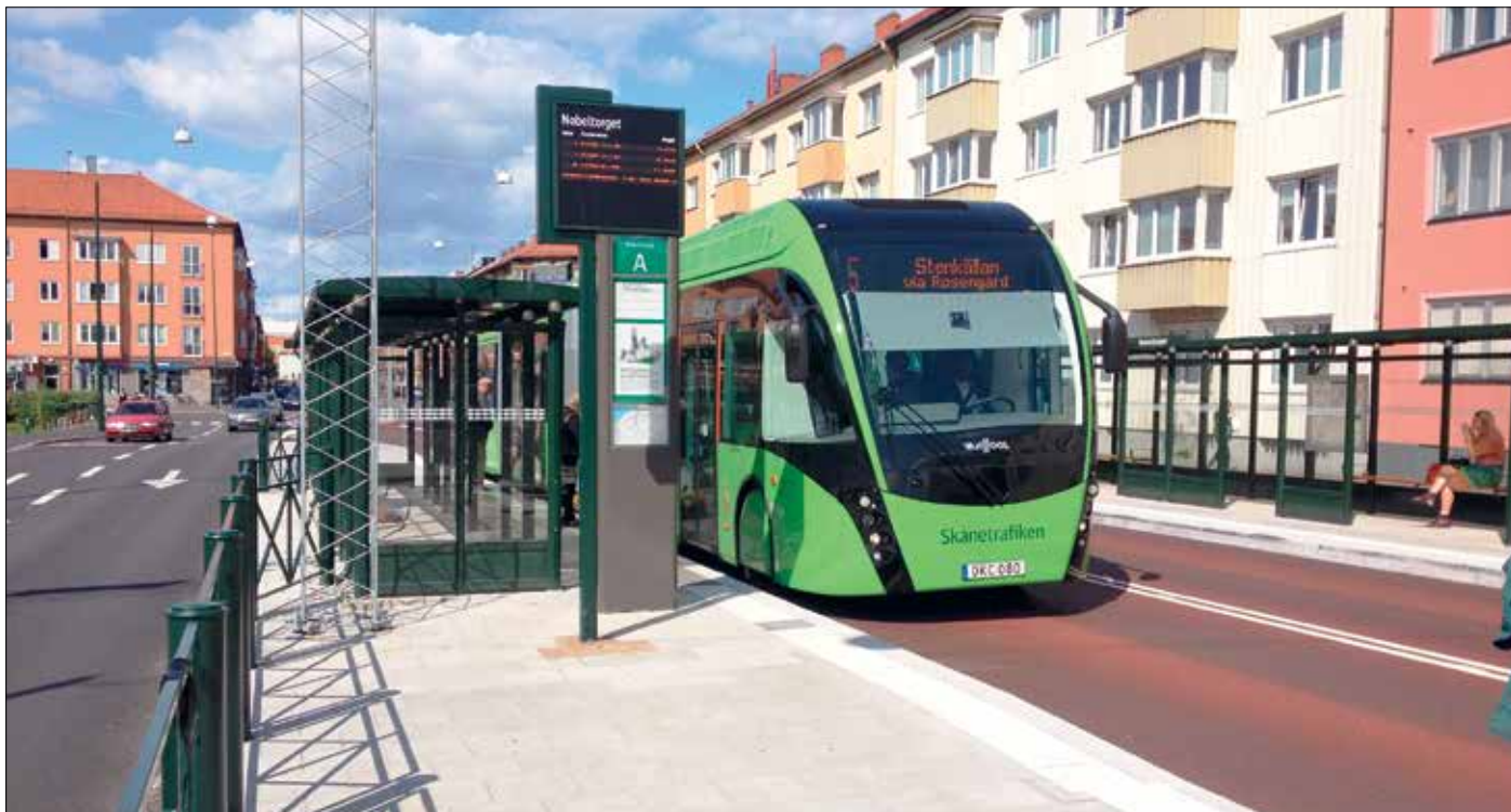
Malmöexpressen vid mittförlagda hållplatsen Nobeltorget.
