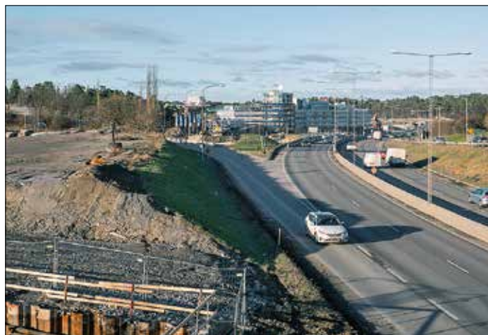
Vy från Bällstavägen norrut mot Solvalla, med markarbeten utmed Ulvsundavägen.
