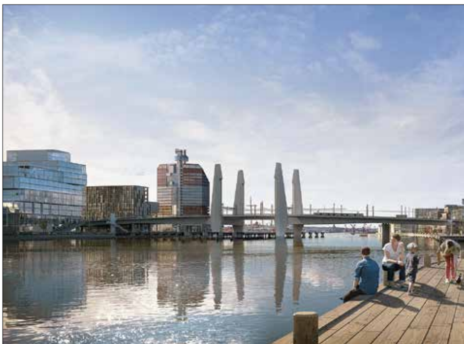
Hisingsbron i Göteborg invigs under 2021 och är ett viktigt stadsbyggnadsprojekt. Det blir en låg brokonstruktion med lyftdel som höjs som en hiss mellan de fyra tornen.
