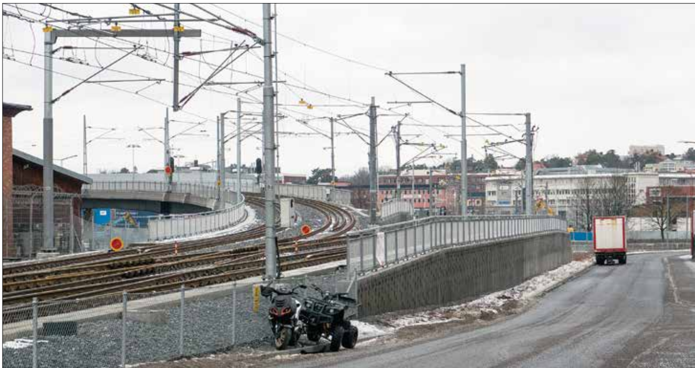
Spåret mot Bromma flygplats vid uppfarten till bron över Ulvsundaleden är ordentligt avstängt med hindermärken.
