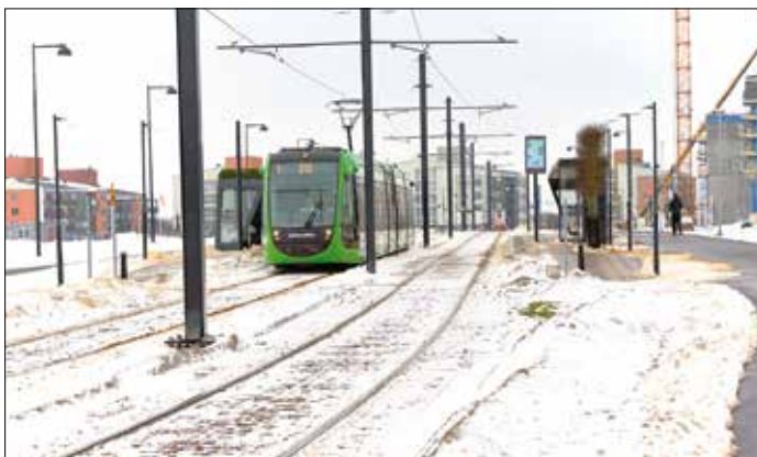
Den 16 februari har plogen passerat Brunnshögstorget. Plogning måste ske med fordon som driver på stålhjulen då fordon som driver med gummi hjul skadar den isolering som är monterad på sidorna av rälererna.
