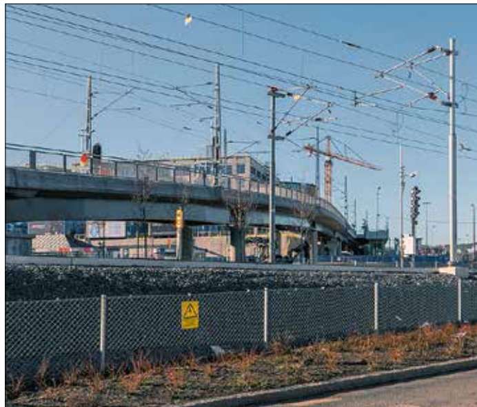
Sträckan mot Bromma flygplats har dels de särskilda kontaktledningsstolparna i H-profil som utarbetats för Kistagrenen, dels konventionella "SJ"-stolpar. Till höger den klassiska rundstolpen som finns på övriga Tvärbanan.
