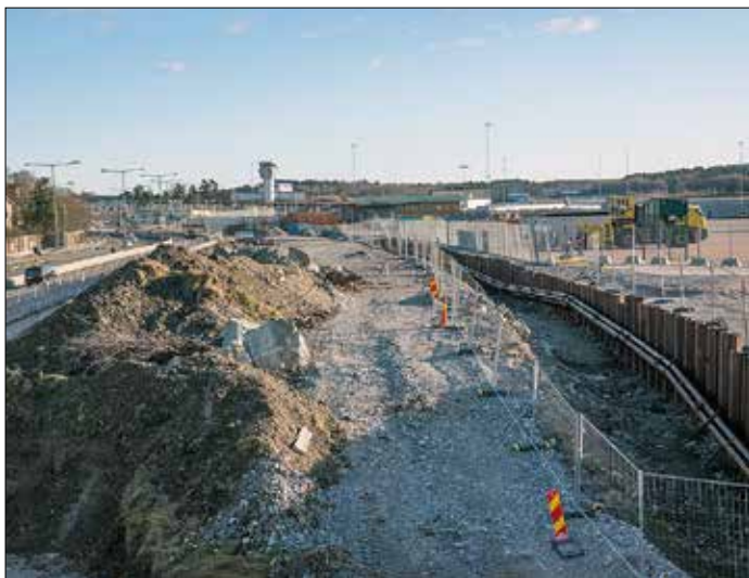
Markarbeten utmed Ulvsundavägen mellan Bällstavägen och flygplatsen.
