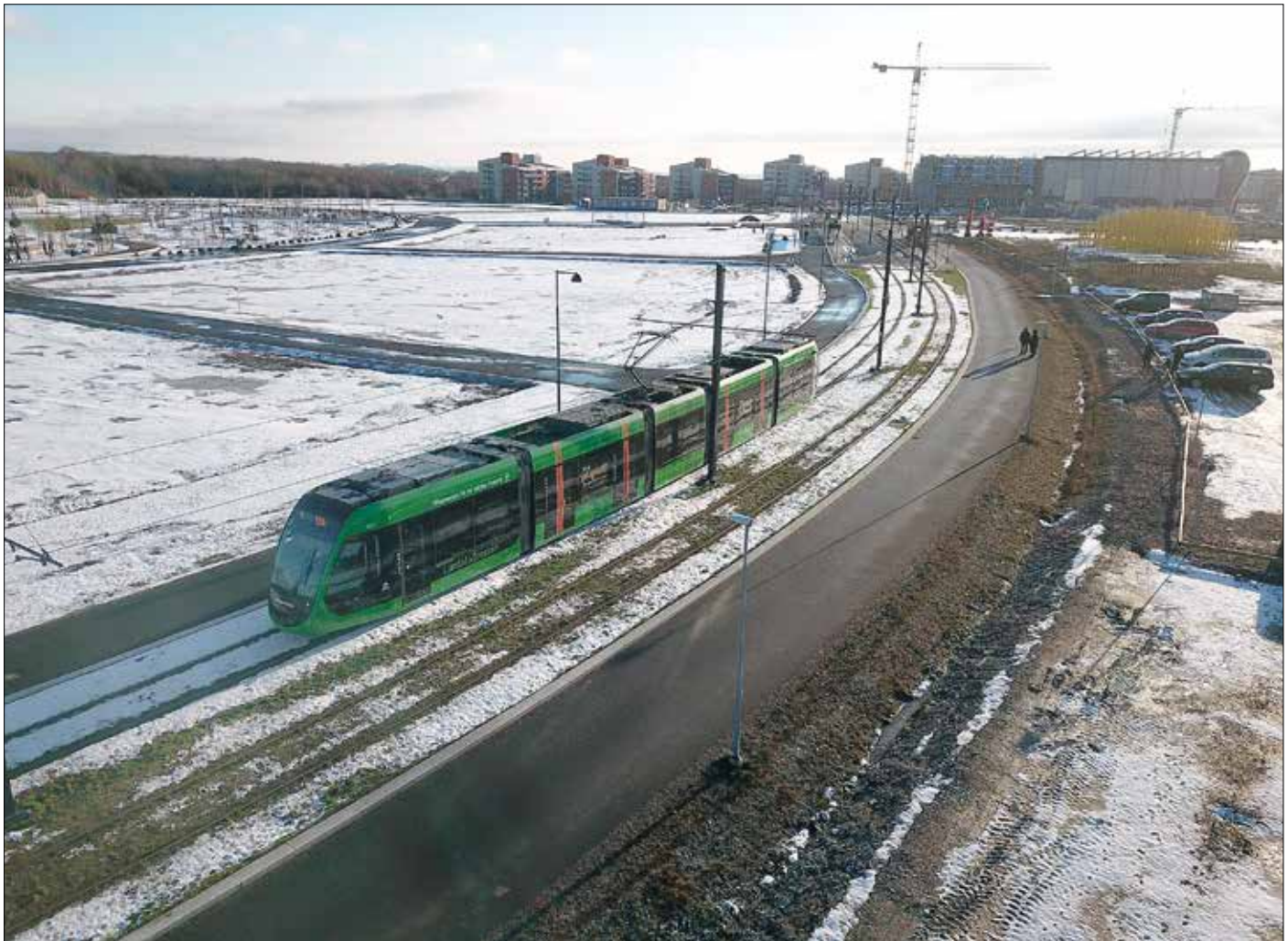
Brunnshög och Brunnshögstorget den 9 januari. Här ska det under 2021 byggas bostäder.
