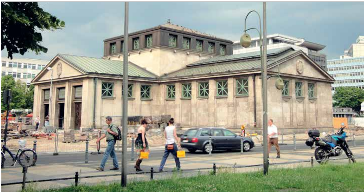
Den vackra tunnelbanestationen Wittenbergplatz är en av Berlins äldsta och invigdes år 1902. Den skadades svårt under kriget men återuppbyggdes under 1950-talet. Nu är det åter dags för renovering, som pågår just nu.
