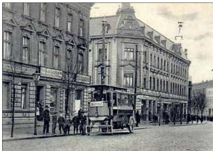
En kort tid under 1901 provades denna ur-trådbuss i Eberswalde, system Lombard-Gerin. Det elektriska fordonet hämtade elkraft från en dubbeltrådig kontaktledning ovanpå vilken en liten elmotordriven kontaktvagn, "trolley", rullade, ansluten med kabel. Kreisarchiv Barnim
