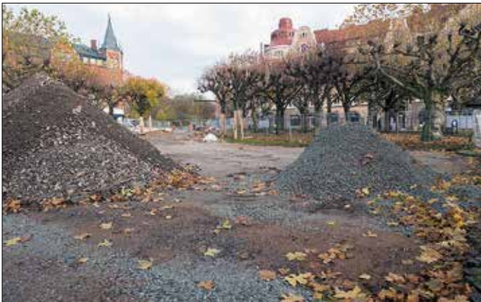
Clemenstorget med platsen för den blivande ändhållplatsen, just nu avröjd, med några grushögar, bakom staket.
