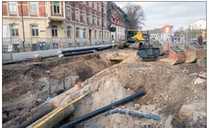
I oktober pågick ännu tunga arbeten med ledningsförflyttningar i korsningen mellan S:t Laurentiigatan och Bredgatan, invid Allhelgonakyrkan.
