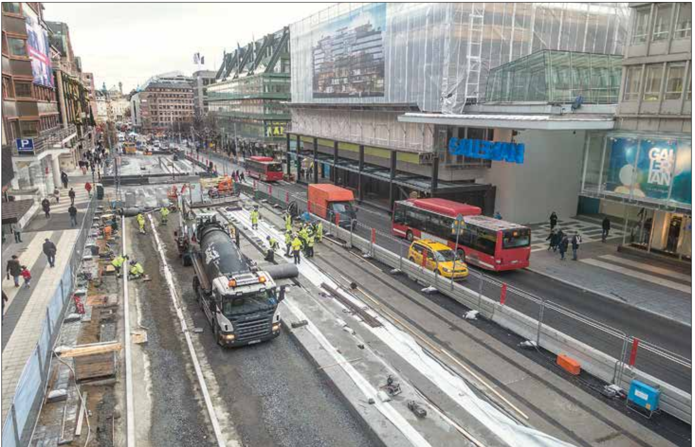
På Hamngatan pågår den 21 november 2016 arbeten med tätskiktsrenovering och gjutning av spårkroppar för den blivande spårvägen. Just här var den första ändhållplatsen för Spårväg city belägen. Stora arbeten pågår också i kvarteret som innehåller köptemplet Gallieran till höger.
