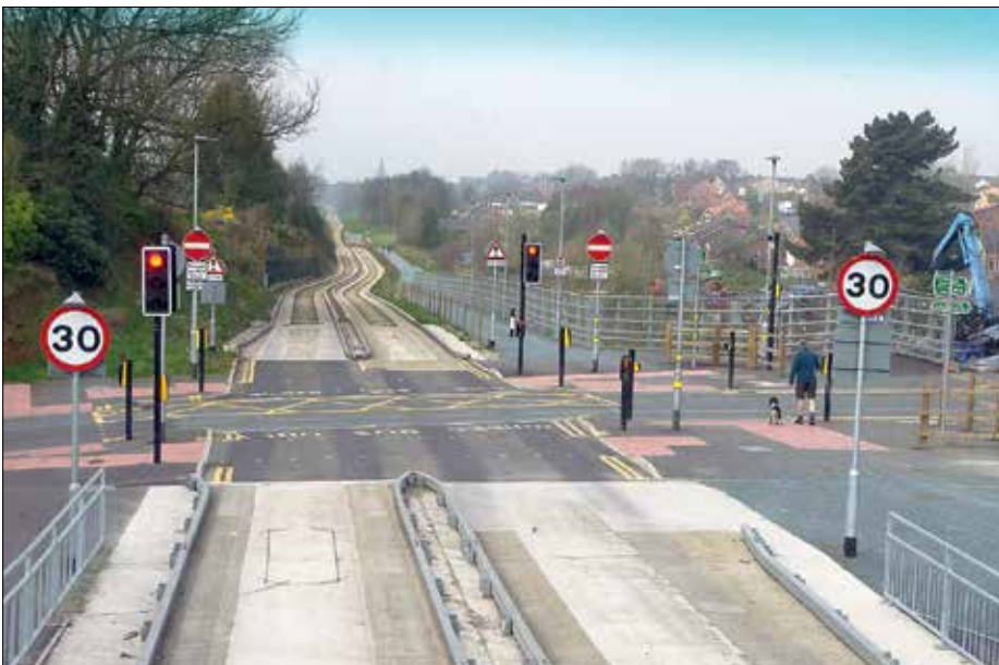
Vid varje korsning med vägnätet finns texten "Guided bus only" på bussbanan. Där är maxhastigheten nedsatt till 30 eller 20 mph (48 eller 32 km/h). Till höger syns gång- och cykelvägen.
