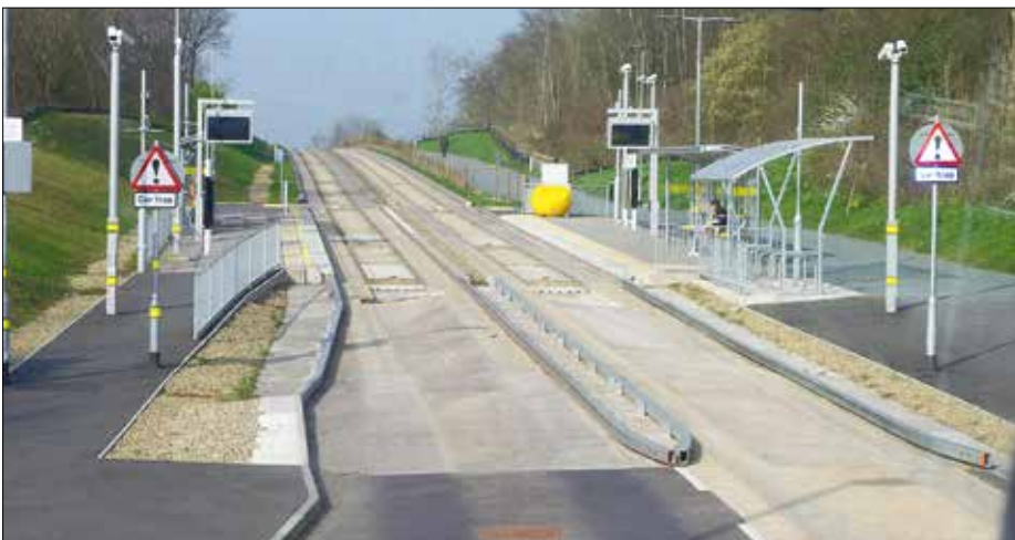
Hållplats på bussbanan med "tratt" till vänster, för bussar som ska in på betongspåret (vänstertrafik). Här finns även spårviddshinder för bilar ("Car trap").
