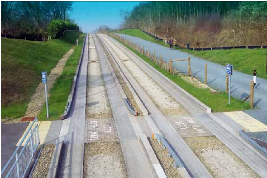
Obevakad korsning för fotgängare på bussbanan. Skyltar uppmanar att titta åt båda hållen. Vid korsningarna för fotgängare finns skyltar "Busway – look both ways" som inspirerats av skyltarna vid spårvägs korsningar, "Tramway – look both ways".
