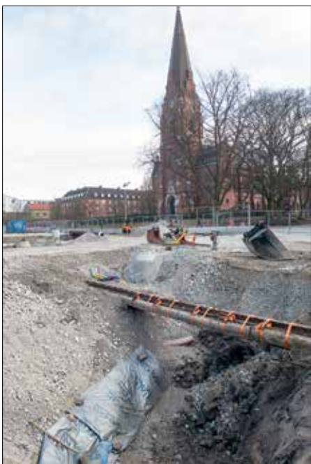
Djupa ledningsarbeten i närheten av Allhelgonakyrkan i centrum. Till vänster utanför bilden går Laurentiigatan.
