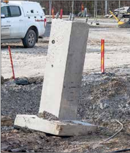
Till nästan 80 procent placeras stolpfundament av samma typ som Trafikverket använder för järnvägen.
