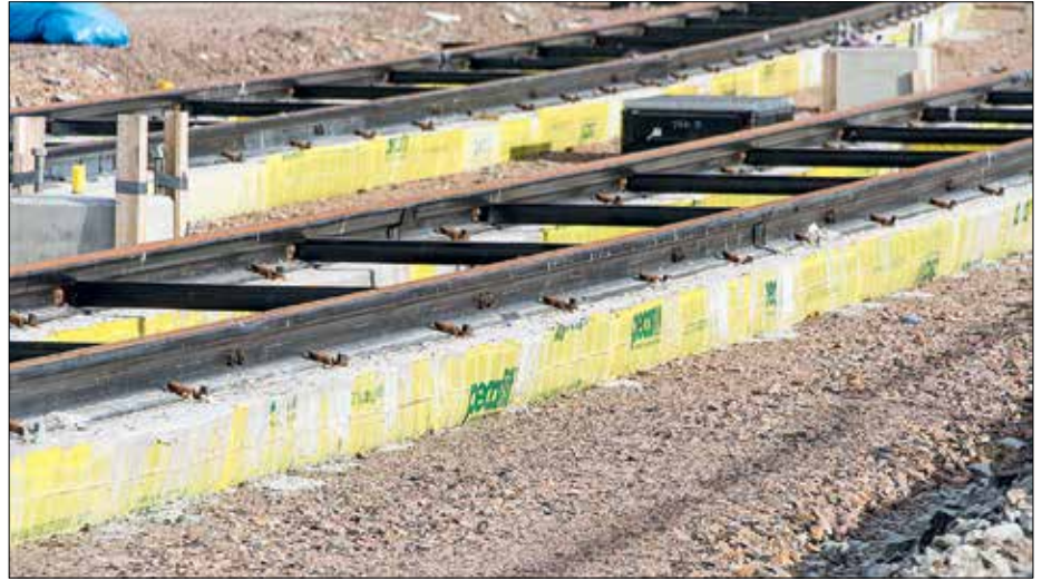
Färdiggjuter spår. Rester av gjutformar för längsgående betongbalkar kan ansas. Gjutformarna placeras ut, inklusive armering, rälerna justeras till rätt position efter sammansvetsning och montering av fästansordningar. Betongbalkarna gjuts och spåren fixeras därmed i slutligt läge.
