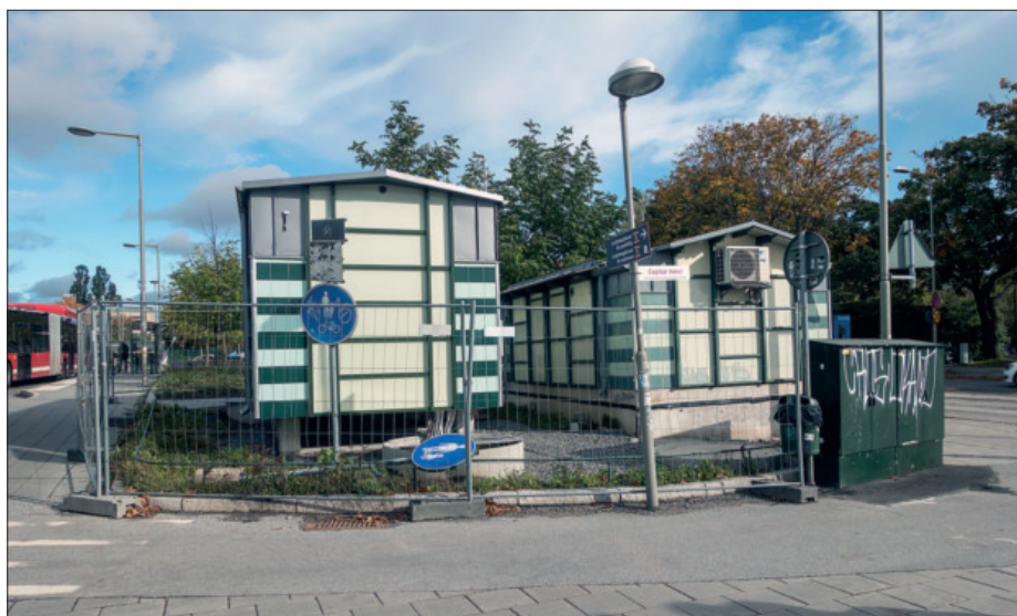
Nya så kallade teknikhus har uppförts utmed banan, i samma stil som de byggnader som restes när Tvärbanan byggdes under sent 1990-tal. Nytt hus till vänster i bild, här vid Årstaberg.
