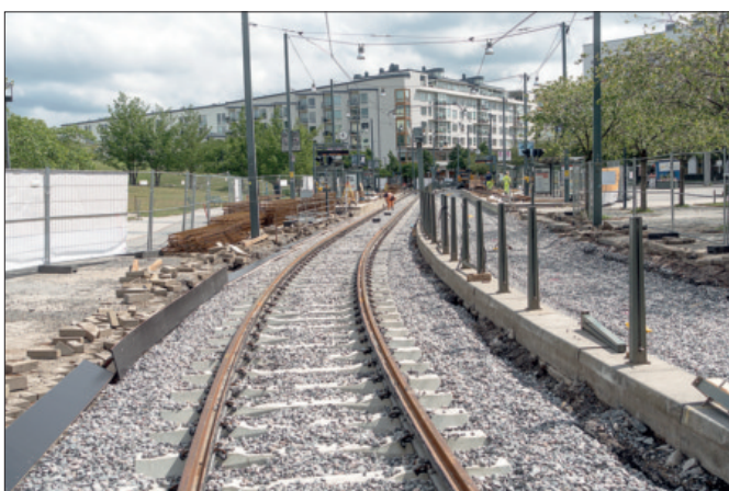
Nylagt slipersspår i kurvan ut från hållplats Luma, den så kallade Adidaskurvan, efter butiken i närheten med produkter med samma namn.
