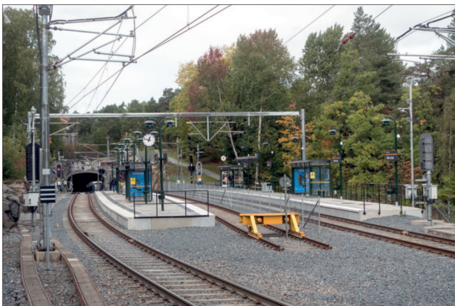
Efter avslutad ombyggnad har hållplats Alviks strand nu ett vändspår och två nya plattformar. De gamla träplattformarna har ersatts.
