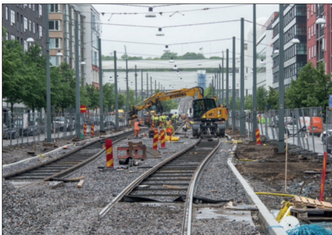
Från Mårtensdal och till strax bortom hållplats Luma var det mycket stora arbeten. Det största av dem var att anlägga vändspåret, liksom spårbyten vid hållplatserna Mårtensdal och Luma.
