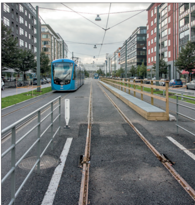
Nya vändspåret i Hammarby allé mellan hållplats Mårtensdal och Lumaparken. Notera de båda spårspärrarna närmast. Se också bild på sidan 16.
