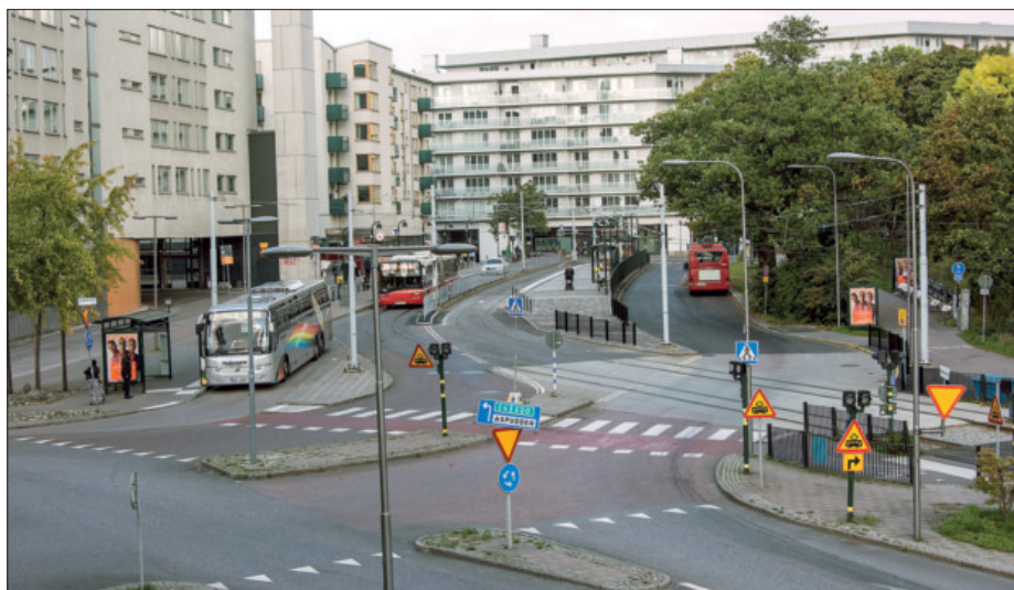
Vid Liljeholmen breddades plattformen på norrspåret, i riktning Solna station. Där var det tidigare mycket trångt när avstigande och påstigande passagerare trängdes.
