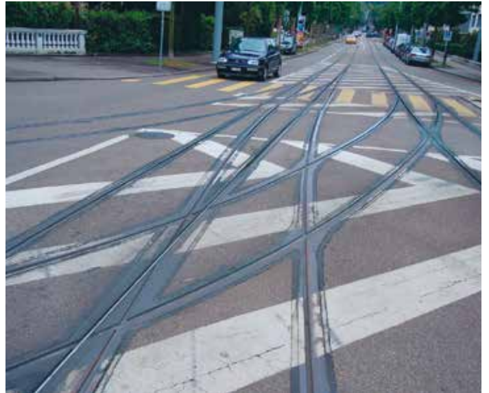
Det krävs ett visst hantverk för att knäpa ihop ett snyggt växelkomplex. Detta hittar man på Münchensteinerstrasse i schweiziska Basel.
