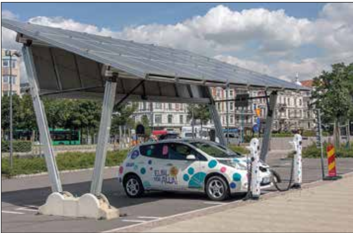
Batteribil laddas under solpanel.
