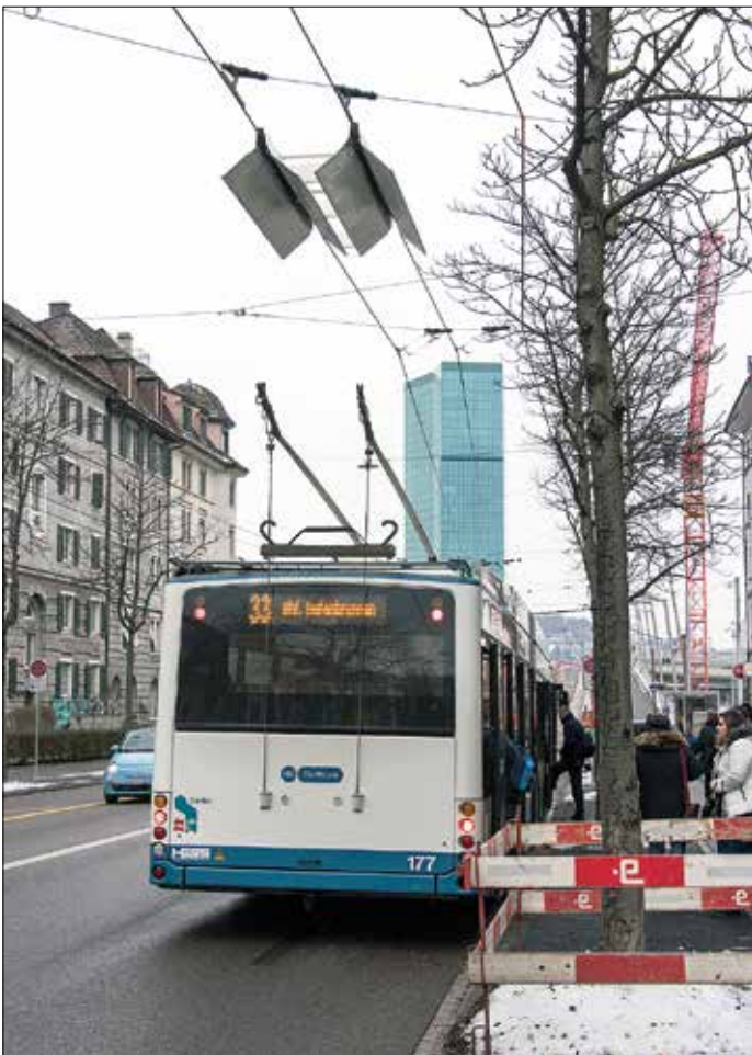
Snabb uppfällning av strömvagnarna enligt klassisk metod i samband med hållplatsuppehåll. Bussen körs tätt intill kantstenen och stannas i längsled med en stolpe som riktmärke för föraren, som fjärrmanövrerar strömvagnarna från förarplatsen.
