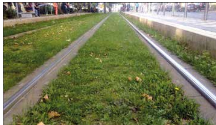
För kommande gröna spår i Stockholm har valts ett system som i princip innebär att rälererna omges av omkring en meter långa distansstycken av gummimaterial som i princip ”knäpps” ihop, varvid undviks att gräs och humus kommer för nära rälererna.
