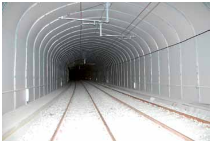
Bybanens tunnlar er vann- og frostsikret med WG Tunnelhvelv T100
