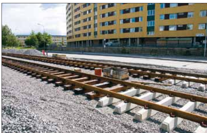
Nära den blivande hållplatsen Nitentorget finns en sträcka där träsliprar används för att minska ljudet från spårvagnarna.
