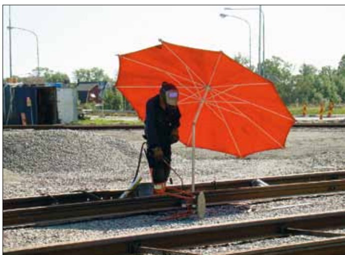
Den 6 augusti pågick spårsvetsning i slingan för den första etappen intill Trumpetaregatan.
