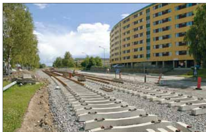
Konventionellt spår med betongsliprar utmed Hagebygatan nära den blivande hållplatsen Nitentorget.
